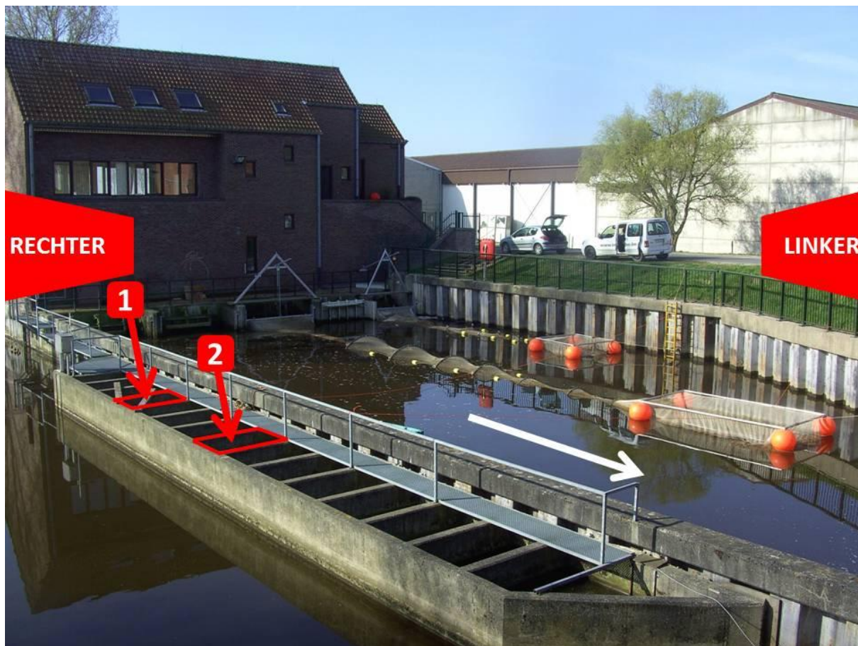
Fig. 22. De compartimenten van de De Wit vistrap waarin een fuik wordt geplaatst. De fuiken bemonsteren de stroomopwaarts (compartiment 2) en stroomafwaarts (compartiment 1) migrerende vissen. De witte pijl duidt de stroomrichting aan; RECHTER = rechteroever; LINKER = linkeroever.
