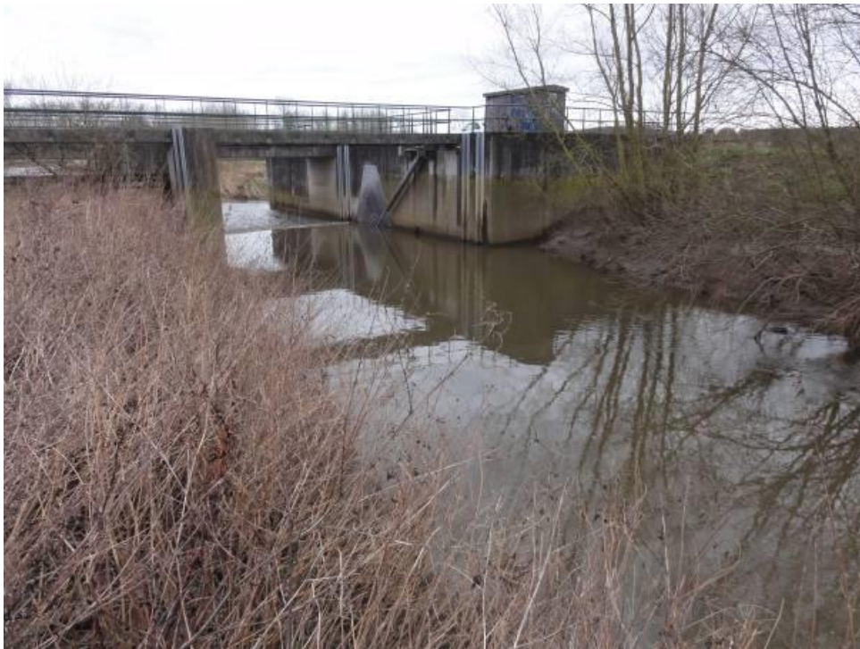
Figuur 6 Zicht op klepstuw K31 tussen de Demer en de Zwarte Beek in Diest. Vooraan is de Demer zichtbaar, voorbij de stuw de Zwarte Beek.
