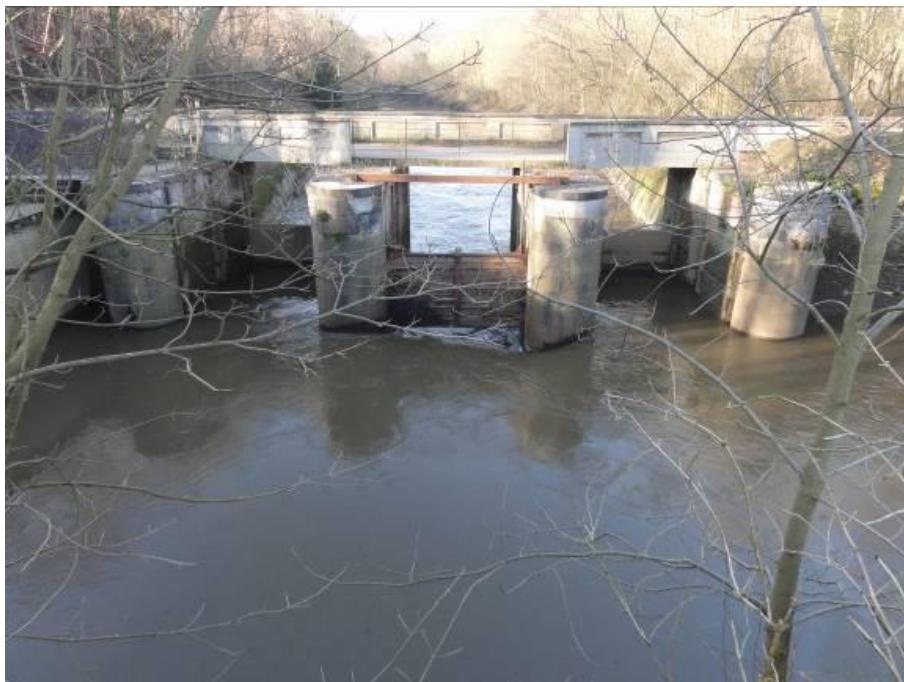
Figuur 4 Stroomafwaarts zicht op het kunstwerk en potentieel vismigratieknelpunt de Grote Steunbeer in Diest (foto stroomafwaarts). Het water stroomt onder de centrale schuif, die naargelang het debiet neergelaten kan worden. Rechts en links van de centrale schuif bevinden zich vaste muren, waar bij hoog debiet het water over stroomt.
