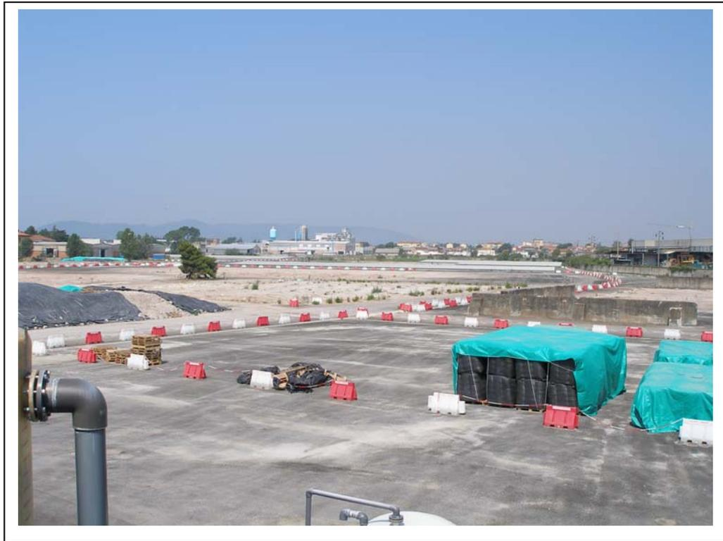
**Figura 2.11** Visione panoramica dell'ex sito industriale. Da notare che la maggior parte dell'area è stata provvisoriamente asfaltata come provvedimento di messa in sicurezza del sito in attesa di essere bonificato con misure definitive.
