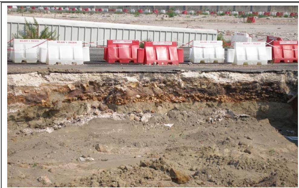
Figura 2.12 Nella foto uno scavo aperto all'interno del sito industriale. In evidenza lo strato rossastro delle ceneri di pirite e, immediatamente sotto, un orizzonte di terreno sabbioso di colore grigio chiaro. Campioni di entrambe le tipologie di suolo sono state utilizzate per le prove di fitorisanamento con *P. vittata*.
