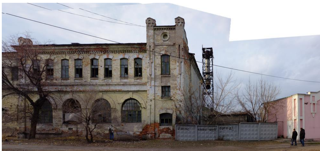
Рис. 3. Фрагмент котельной – бывшая электростанция. Современное состояние (весна, 2013 г.)
