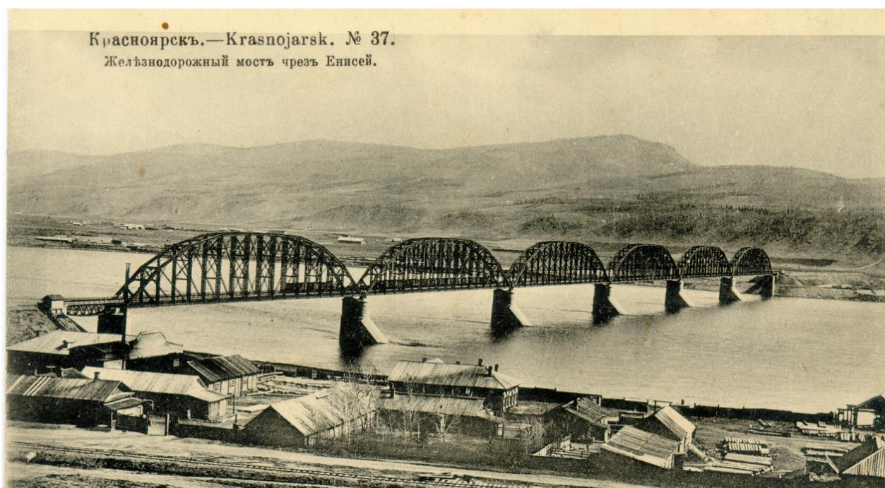
Рис. 3. Красноярск. Железнодорожный мост через р. Енисей. Фотография начала XX в. ККМ
