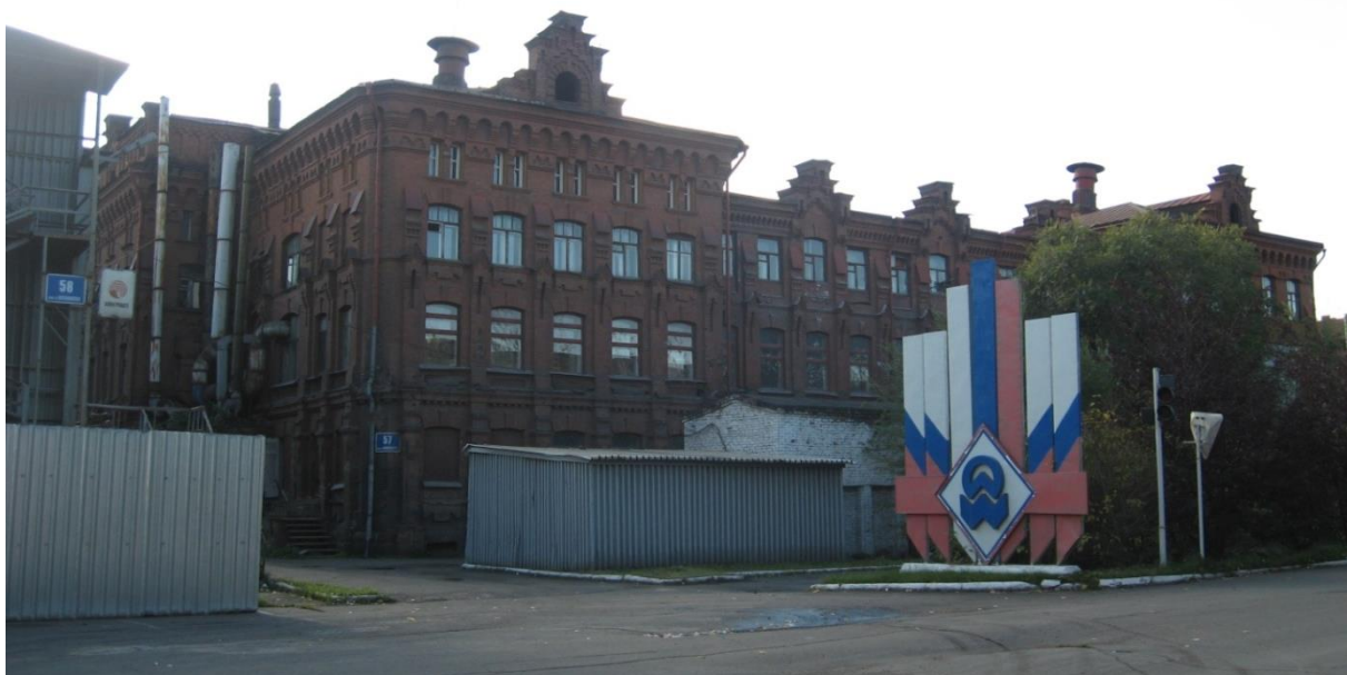
Рис. 4. Красноярск. Здание бывшего казенного винного склада-завода. Главный корпус. Фотография автора. Начало XXI в.
