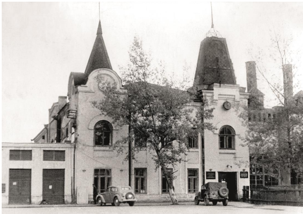
Рис. 5. Красноярск. Здание водопроводно-электрической станции. Фотография 1930-х гг. ККМ
