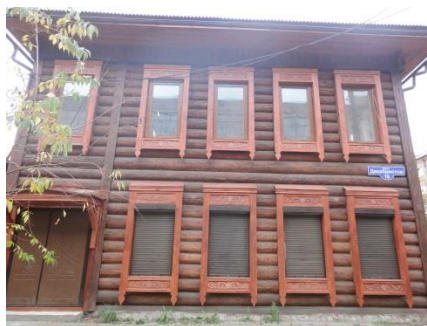
Рис. 12. Жилой дом по ул. Декабристов, 16 [4]
