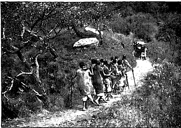
Abb. 38. Transport der Bahnmaterialein.
