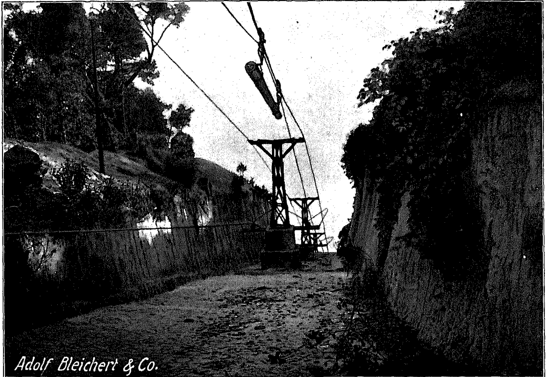
Abb. 24. Einschnitt beim Uebergang der Linie über den Plateaurand.
