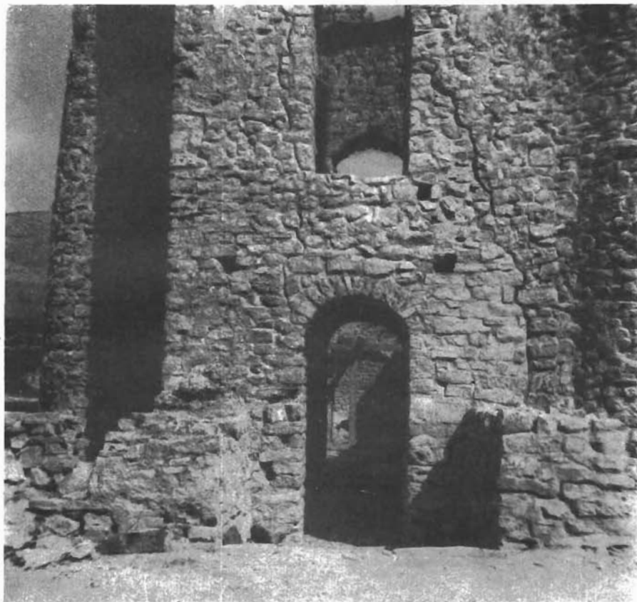
Sl. 14. Konzerviranje crkve sv. Spasa. Slika pokazuje restaurirani i rekonstruirani dio pročelja zvonika. Novo od staroga odijeljeno je diskontinuitetnom linijom (staro je s krajeva, a novo u sredini)
