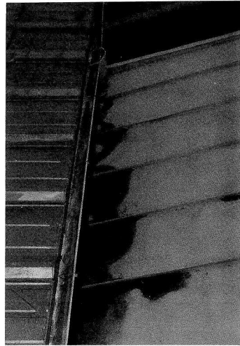
図21 金属屋根の灰のたまり状況
