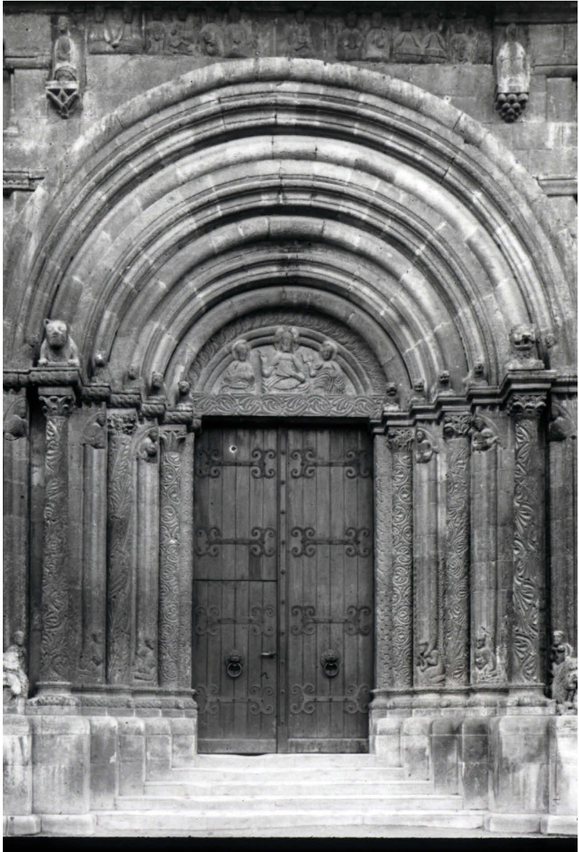
Abb. 2: Regensburg, ehem. Schottenkirche St. Jakob. Nordportal. Um 1150/60
