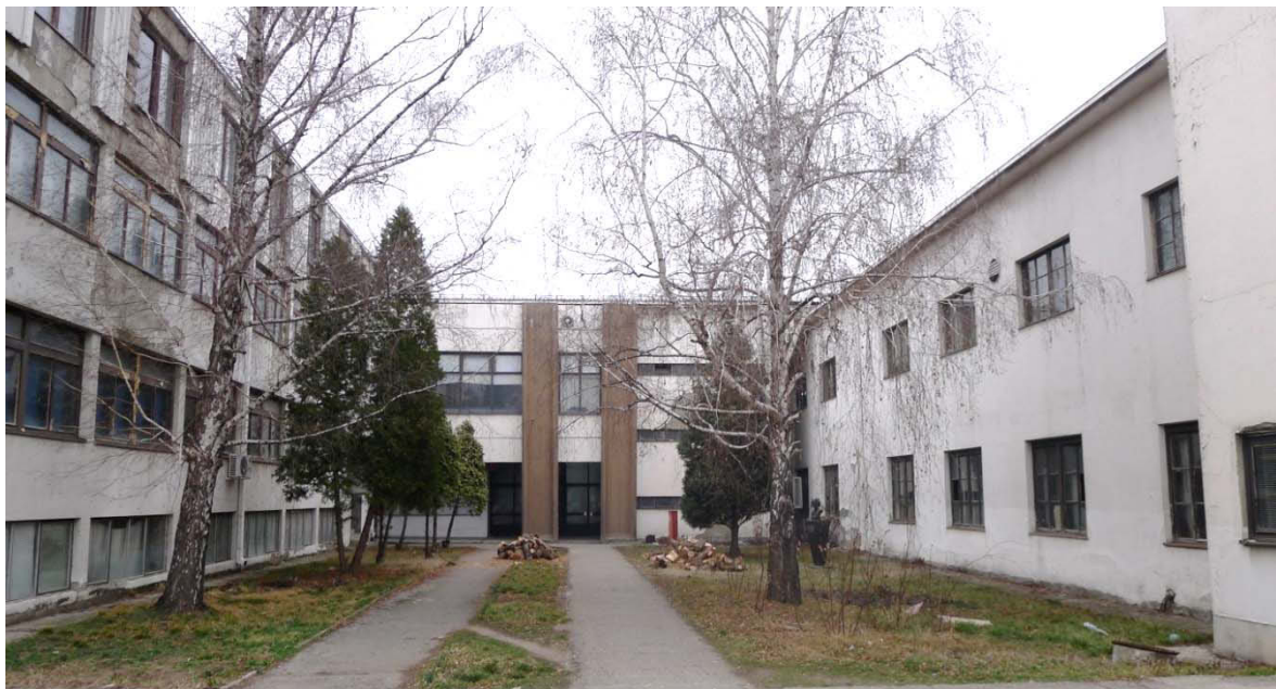
Abb. 26: Auf dem Betriebsgelände des Textilkombinats Branka Dinić (eigene Aufnahme 22.02.2014)
