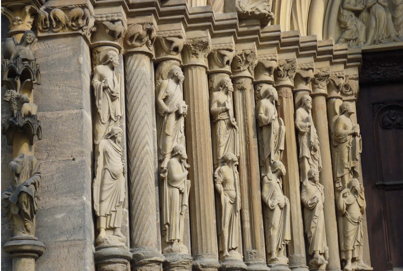
Abb. 15: Bamberg, Dom. Nordseite, Sog. Fürstenportal. Blick auf das östliche Gewände in der Frontalansicht. Um 1220/25
