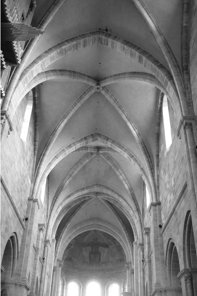
Abb. 1: Bamberger Dom, Mittelschiffgewölbe nach Osten
