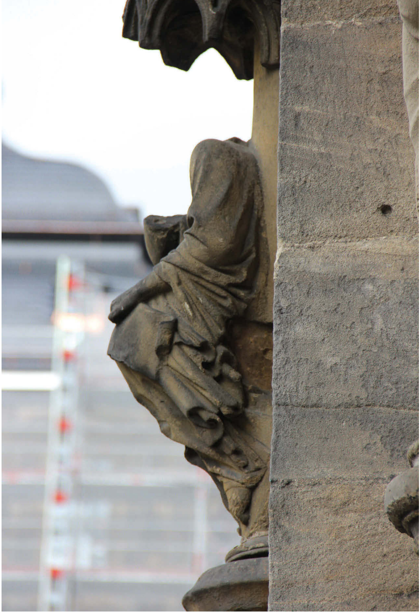
Abb. 7: Bamberger Dom, Fürstenportal, Prophetenfigur unter der Ecclesia, mit Abbruchstelle des rechten Armes
