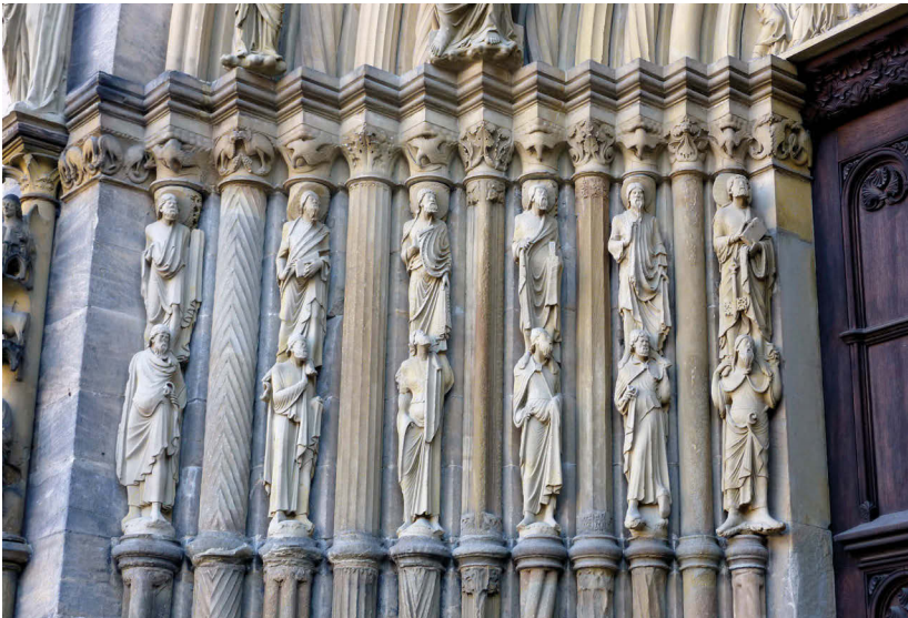
Abb. 16: Bamberg, Dom. Nordseite, Sog. Fürstenportal. Schrägblick auf das östliche Gewände. Um 1220/25
