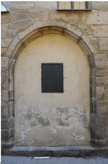
Abb. 9: Südfassade. Nachträglich eingebrochenes Südportal
