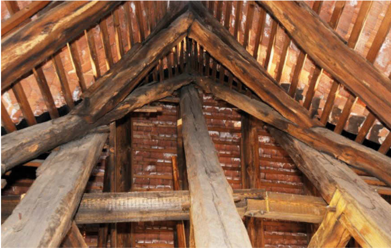
Abb. 18: Anschluss des Dachwerks über dem Nordflügel an das Dachwerk über dem Ostflügel. V-förmiges Begrenzungsholz, auf das mit Schifterschnitten die Gratsparren aufgesetzt sind.
