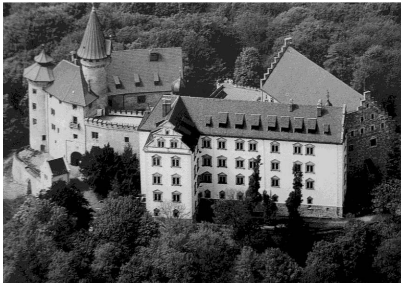
Abb. 4: Heldburg, Kreis Hildburghausen, Thüringen, Ansicht von Südosten
