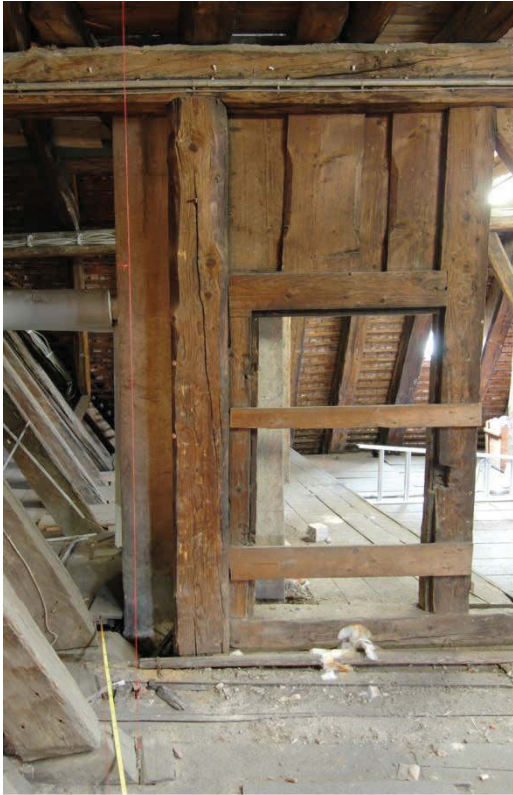
Abb. 20: Nordflügel Spundwand, Rückansicht
