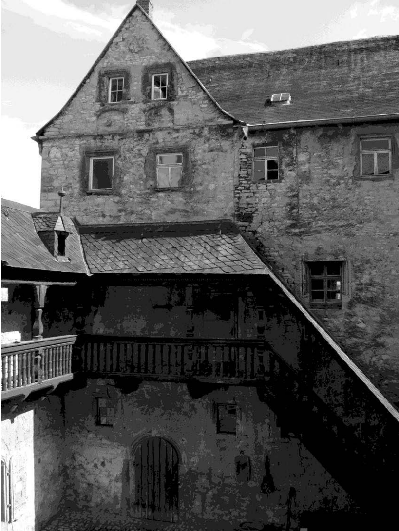
Abb. 9: Kannawurf, Erschließung durch hölzerne Außentreppe und Galerie im ersten Obergeschoss
