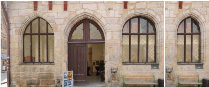
Abb. 7: Nordfassade. Neben dem originalen Portal sind links (östlich) und rechts (westlich) auffällig breite Fenster zu erkennen. Die Gewände sind original und bei der Verbreiterung zum Teil versetzt. Die ursprüngliche Breite des rechten Fensters zeigt die Fotomontage nach der Wegnahme des Kielbogensteins.
