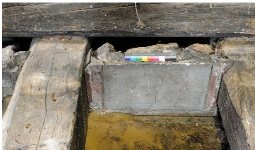
Farbabb. 7: Farbfassungen an den Gefachen der Trennwand der Kleinen Ratsstube zum Treppenhaus (Beitrag Eißing)
