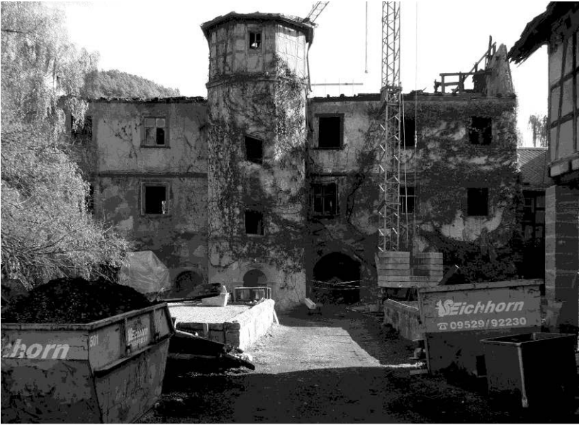
Abb. 10: Ebelsbach, Ansicht von Westen mit Treppenturm
