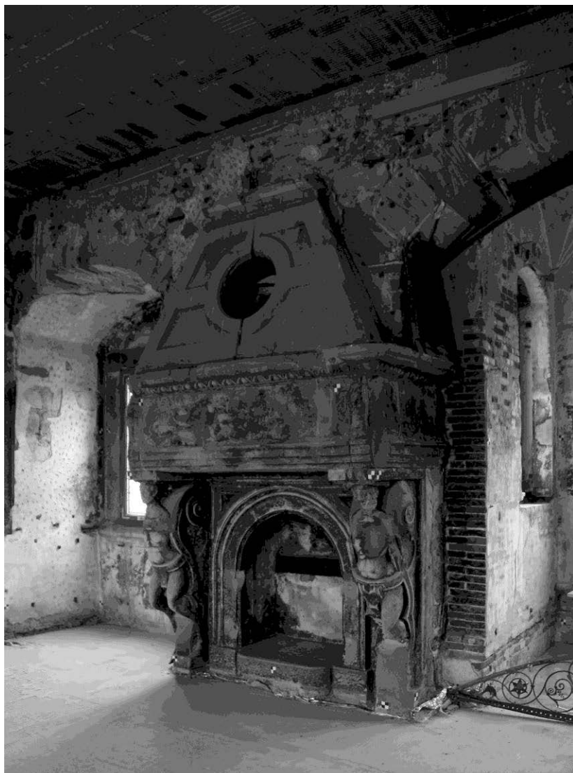
Abb. 6: Heldburg, Französischer Bau, 1. OG. Kamin in Raum 14. 102 (ehemalige Herrenstube)
