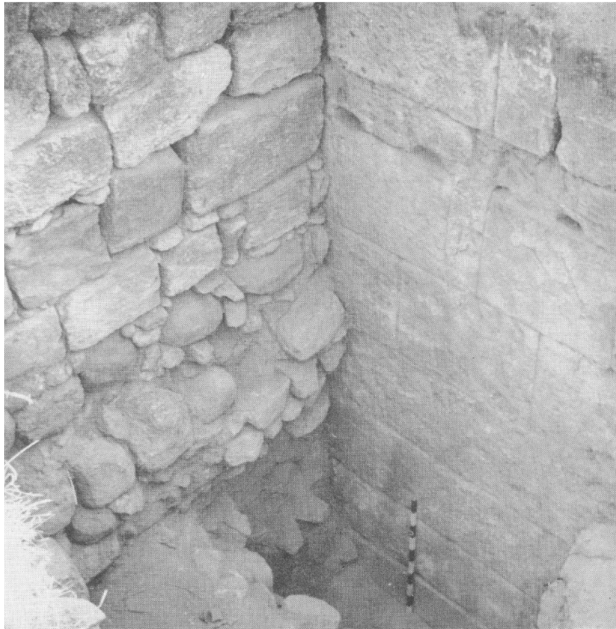
Abb. 22: Die nicht einbindende Mauer 101 an der östlichen Umfassungsmauer 100. (Grabar 1960, Pl. 28 ,A)
