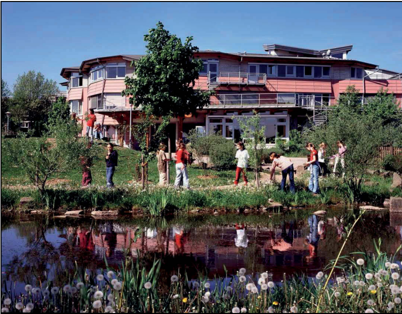
Abbildung 2: Schule in Köln (1996 erbaut)
