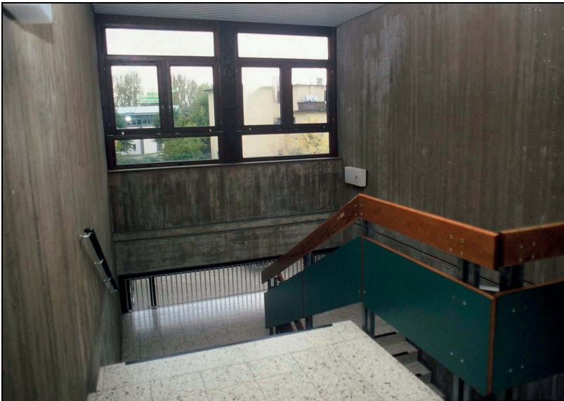
Abbildung 4: Treppenhaus in einem Schulgebäude
