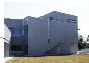
階段上部排気口（自動制御）
