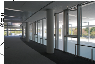
吹抜けをつなぐ窓（手動制御）
