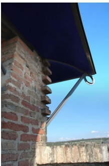
図 40: 塔屋、屋根下面
