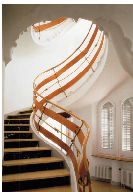
図 13) カタランヴォールトによる階段
