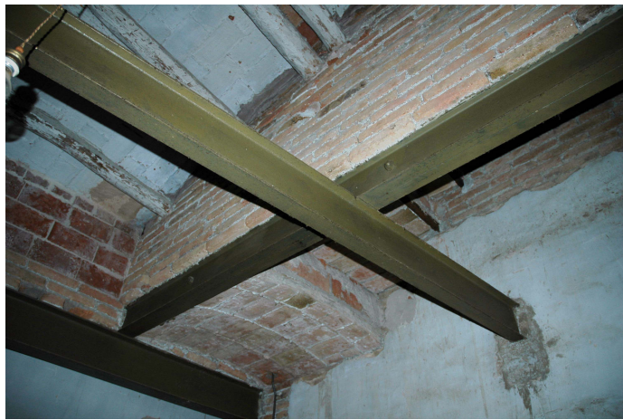
図 39: 塔屋外部階段下部の鉄骨構造
