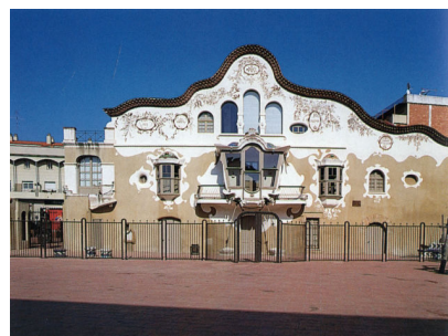
図 32) ファサード全景
