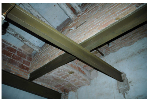
図 24) 増設された鉄骨梁
