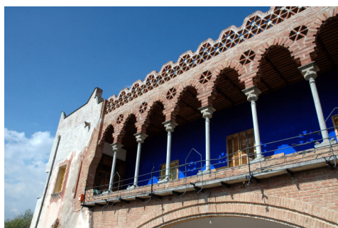
図 20)西側バルコニー見上げ
