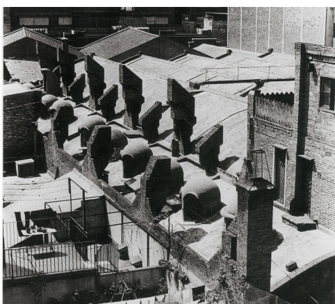
図6) 建設当時の外観
