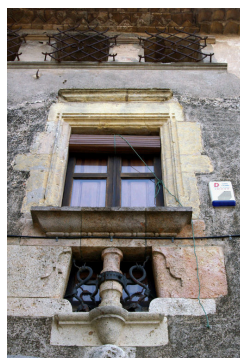
図 22) 玄関上部開口部
