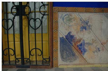
図 48) 2 階南側バルコニー壁面
