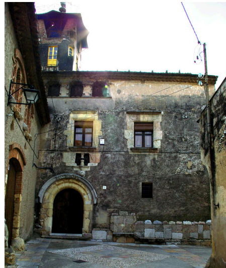
図 44:北側(エントランス側)現状写真
