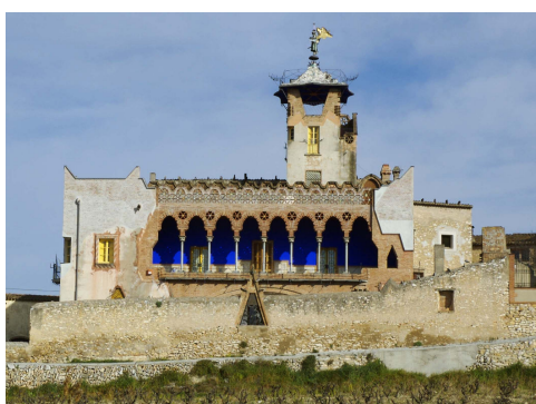
図 49) 南側ファサード外観
