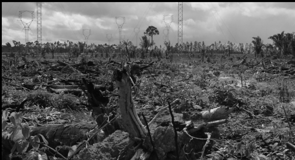
Le linee elettriche della centrale di Jirau attraversano un vecchio castagneto
