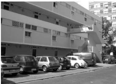
2 - Edifício na Av. EUA, Mário Laginha, Pedro Cid, Vasconcelos Esteves, 1955.
