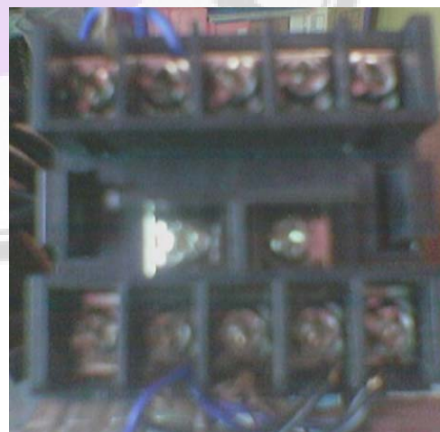
Gambar 3.2. instalasi pemasangan sensor ke timer
