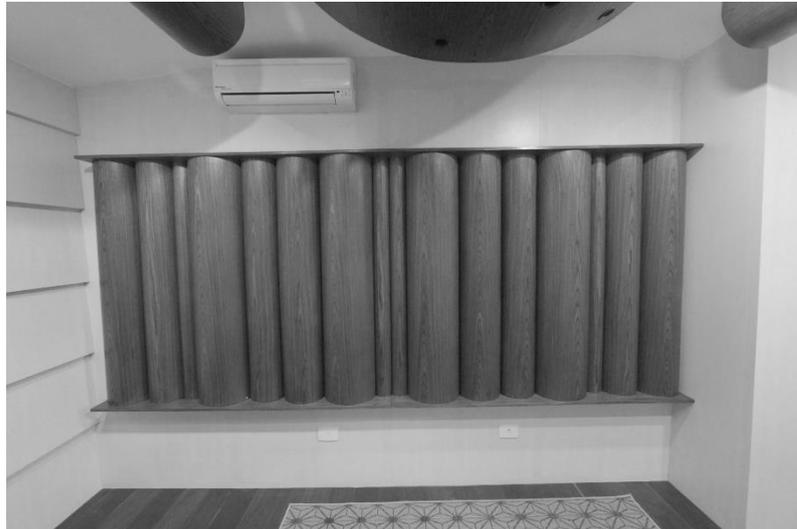
Figura 4.17 – Aplicação de difusores cilíndricos numa sala [25].
