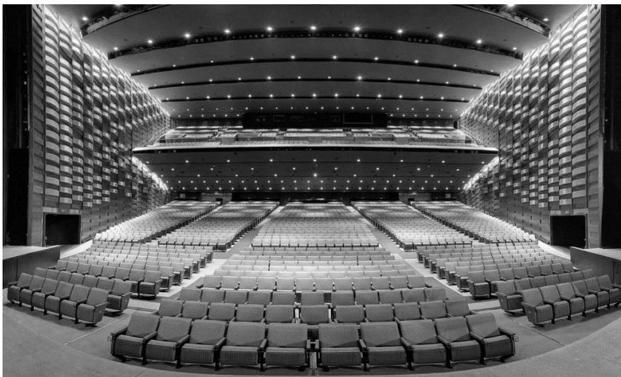
Figura 4.19 - Aplicação de difusores curvos otimizados (*OptiCurve™*) no *Humminbirg Centre*, em Toronto [26]
