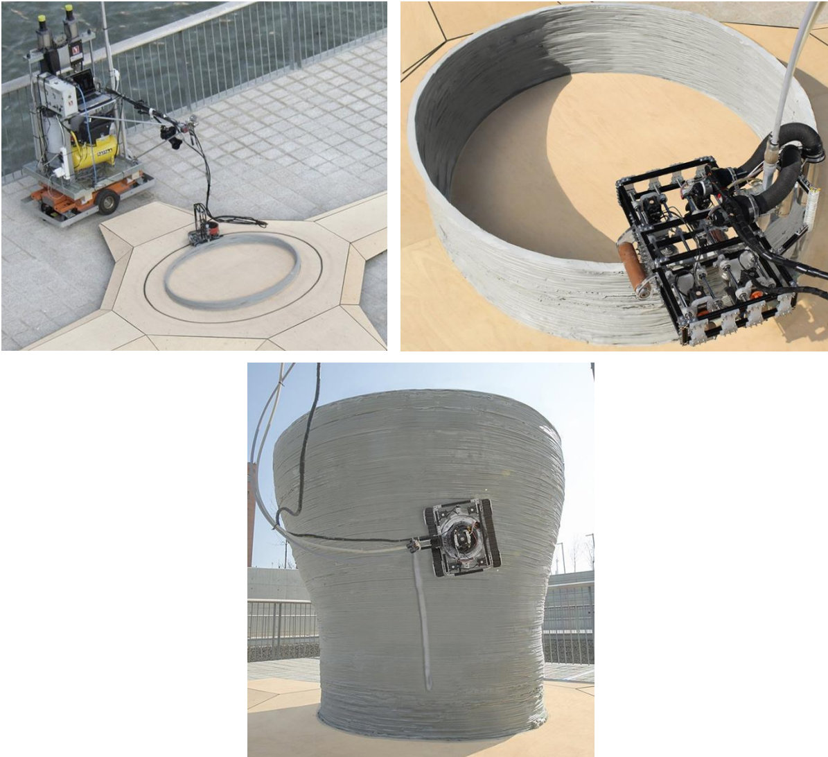
Figura 39 – Sequência dos três robôs a operar, em ensaio experimental [63]
