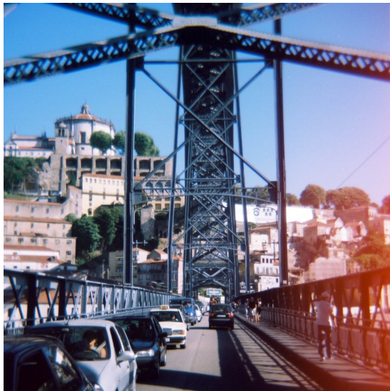
Ponte Luís I
