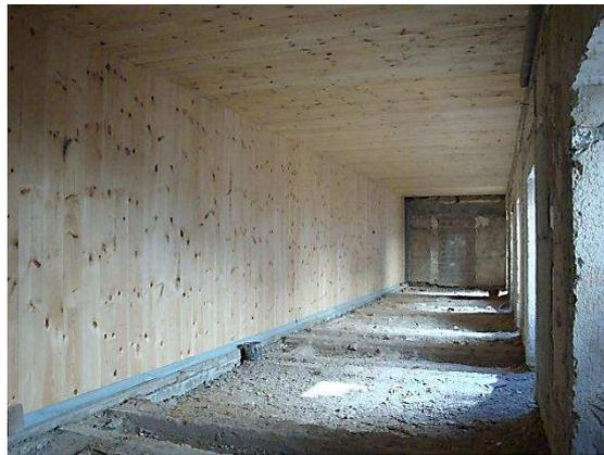
Fig. 4.29 – Casa Repouso, Coimbra – Estrutura de parede e laje concluídas (Cortesia Tisem)
