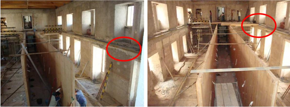
Fig. 3.36 – Pormenor do apoio do painel de laje de CLT na parede existente (Cortesia Tisem)
