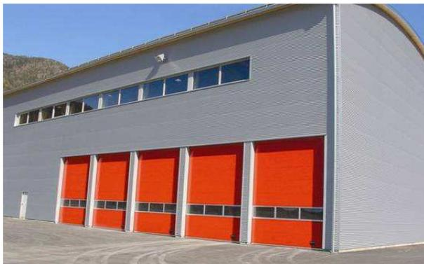
Fig. 3.32 – Edifícios c/ revestimento de chapa metálica [25]
