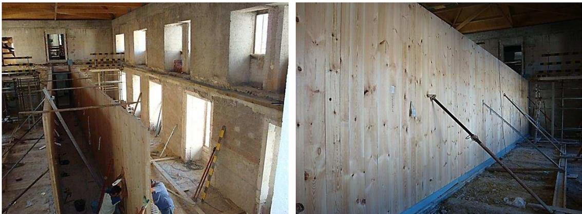
Fig. 4.27 – Casa Repouso, Coimbra – Montagem e escoramento painéis de parede (Cortesia Tisem)
