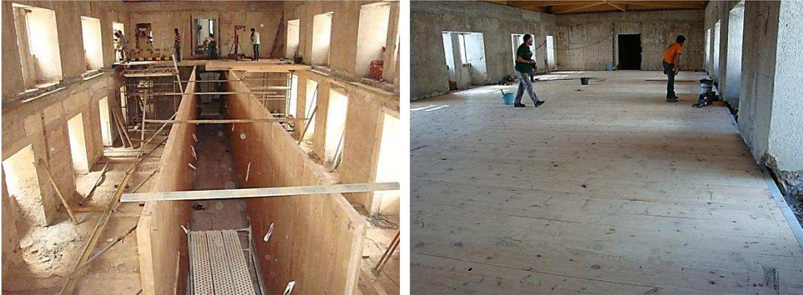
Fig. 4.28 – Casa Repouso, Coimbra – Montagem painéis de laje (Cortesia Tisem)
