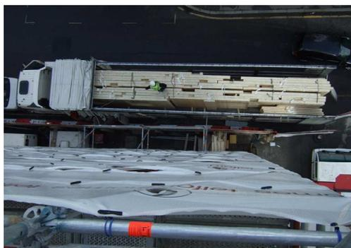
Fig. 4.22 – Acondicionamento dos painéis de CLT, (Cortesia Tisem)
