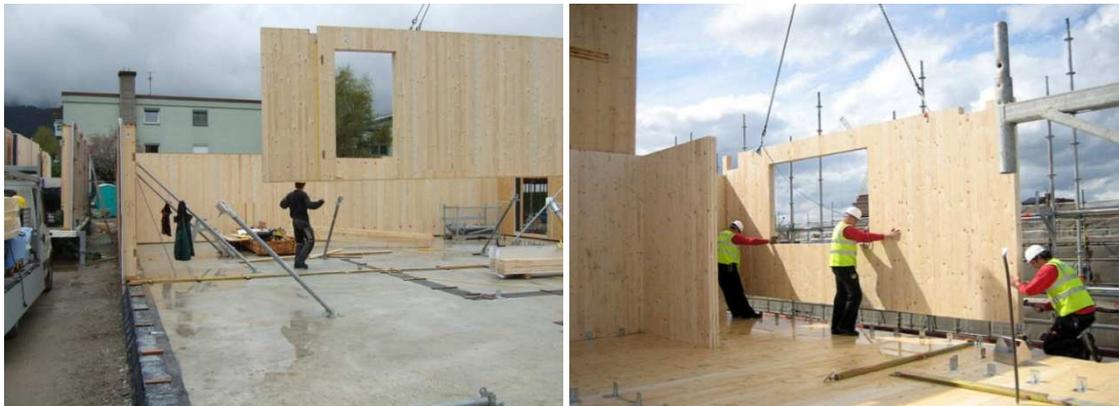
Fig. 3.13 – Aplicação dos painéis em obra [21]
