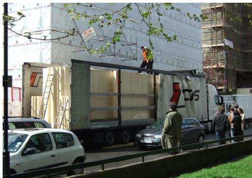
Fig. 4.21 – Transporte dos painéis de CLT,(Cortesia Tisem)
