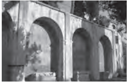
Fig. 2. Il prospetto ad arcate cieche a est della cavea del Teatro romano.
