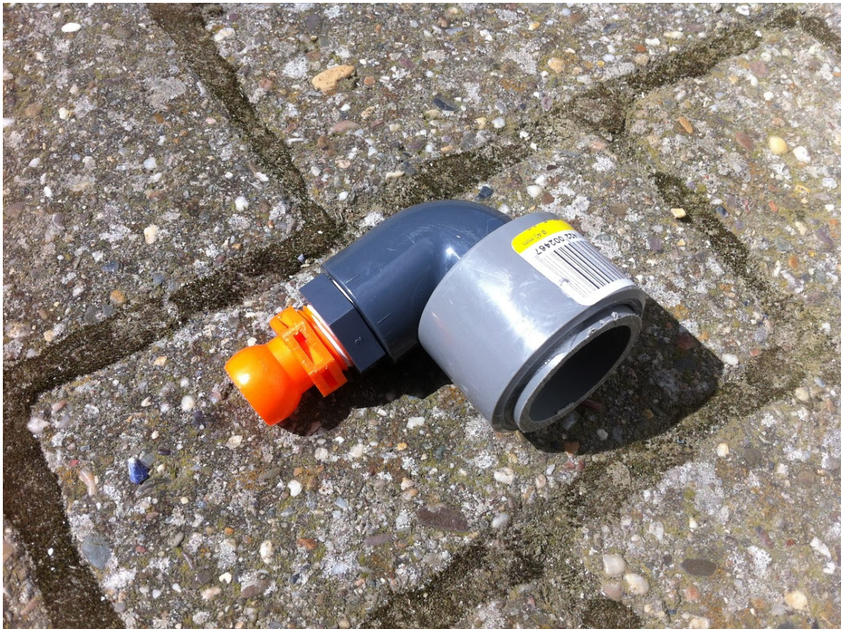
Figuur 3. Detail loc-line pijpje gelijmd in opvolgend verloop ½ inch naar 25 mm, kniestuk 25 mm, pijp 40 mm, verloop 40 naar 50 mm (foto: Joop Coolen/WMR).
