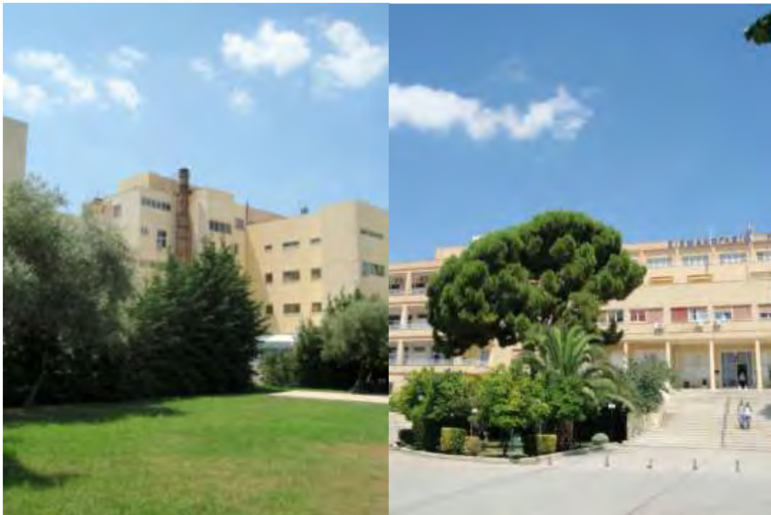
Εικόνα 65. Στην αριστερή φωτογραφία διακρίνεται η παλιά καπνοδόχος και μέρος των νέων εγκαταστάσεων, που ολοκληρώθηκαν την περίοδο των Ολυμπιακών Αγώνων. Στη δεξιά διακρίνεται η είσοδος του Σισμανόγλειου Νοσοκομείου.
