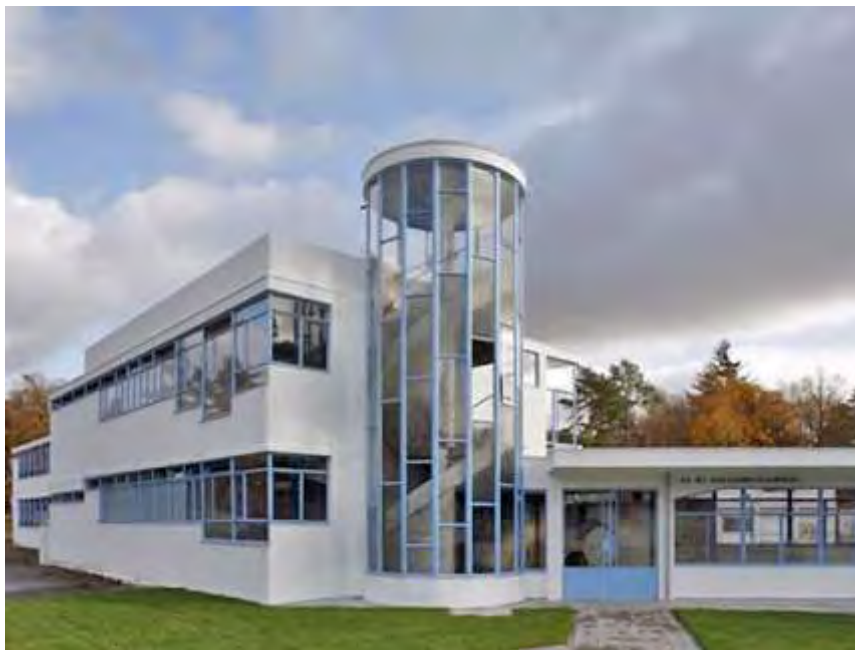
Εικόνα 10. Άλλη ματιά στο αποκατεστημένο σανατόριο Zonnestraal. Ακόμη και η κλίμακα περιβάλλεται από γυαλί, ώστε οι νοσηλευόμενοι να εκτίθενται σε κάθε ευκαιρία στις ηλιακές ακτίνες. Πηγή: World Monuments Fund [Παγκόσμιο Ταμείο Μνημείων] (Ανάκτηση στις 17 Ιουνίου 2015 από http://www.wmf.org/slide-show/zonnestraal-sanatorium ).
