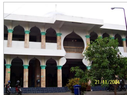
Gambar 3.3: Masjid Al Mujahidin Bangunan Baru
