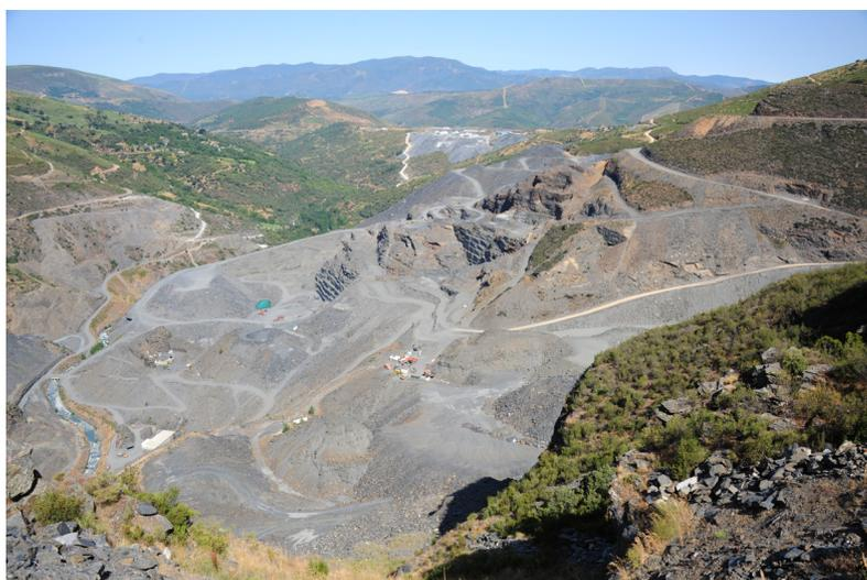
Fig. 4. Vista de una ladera aterrazada con bancos de explotación y pozo de drenaje.
