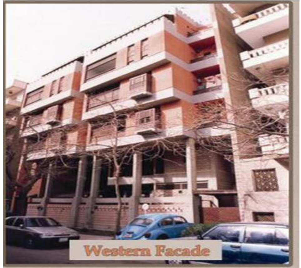
شكل(3-19): مبنى مقر مركز الدراسات التخطيطية والمعمارية
