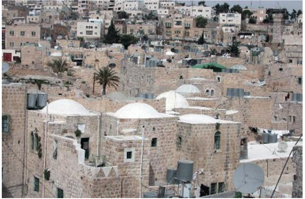
شكل(3-1): صورة للبلدة القديمة في الخليل
