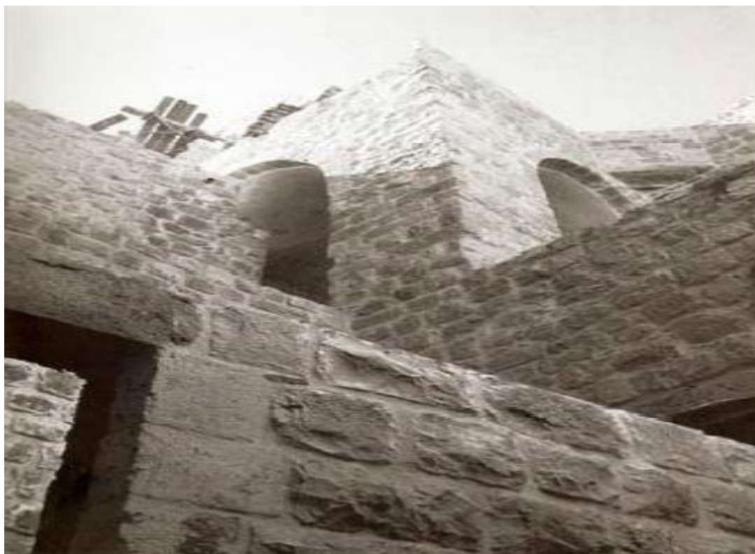
شكل(1-1): استخدام المداميك في احد الاحواش في مدينة الخليل 4
