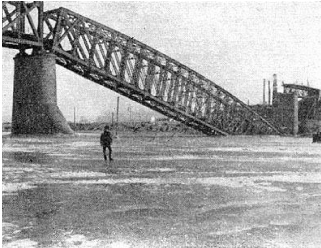
Мост через р. Иртыш, взорванный колчаковцами (1919)
