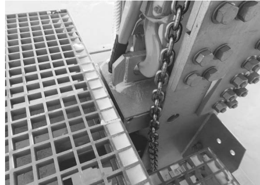
ジャッキアップ用レバーブロック
