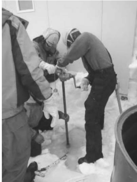
防油堤床面に溜まった燃料をポンプで回収する作業
