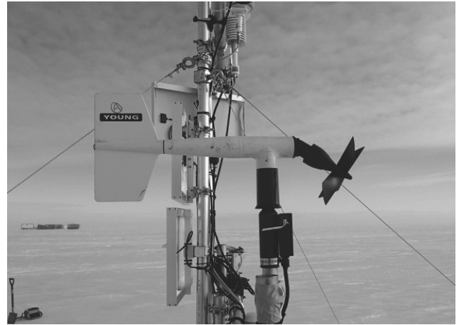
写真Ⅲ.3.2.3.4.1-2 破損した風向風速計
