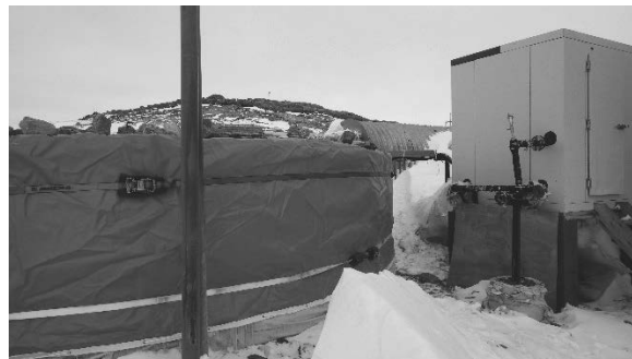
写真Ⅲ.4.1.5-4 覆いシートの更新後
