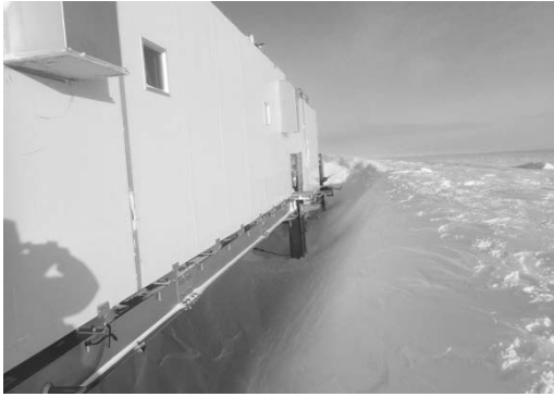
建物北面を風上側から撮影
