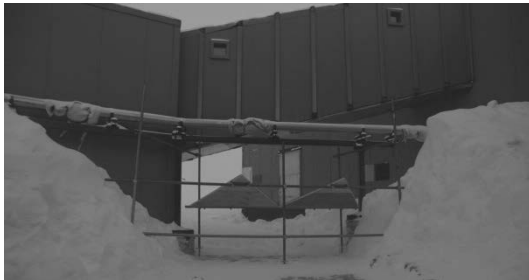
写真Ⅲ.6.2.3-4 正三角形パネル設置の様子
