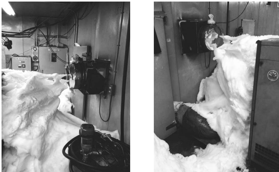
写真Ⅲ.3.3.1.1-1 8月8日ブリザード後の小型発電機小屋内の様子
