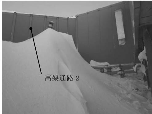
写真Ⅲ.6.2.3-1 4月22～24日のB級 ブリザード後の高架通路2 (風上側から撮影)
