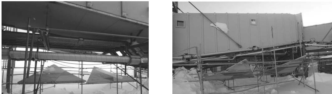
写真Ⅲ.6.2.3-6 正三角形パネル設置の様子（3回目）
