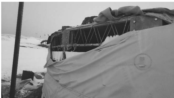
写真Ⅲ.4.1.5-3 覆いシートの更新前
