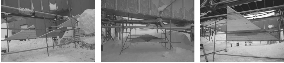
写真Ⅲ.6.2.3-5 正三角形パネル設置の様子（2回目）
