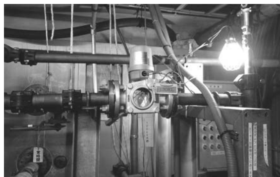
写真Ⅲ. 4. 1. 5-2 循環ポンプの検水器の更新後
