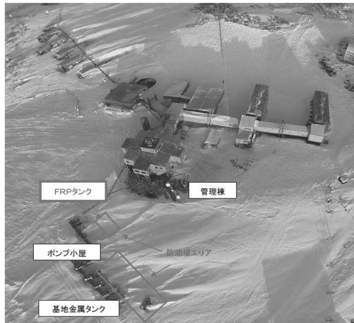
図Ⅲ.2.2.5-1 上空から撮影したFRPタンク、ポンプ小屋の配置
