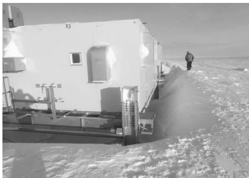
食堂小屋南面
