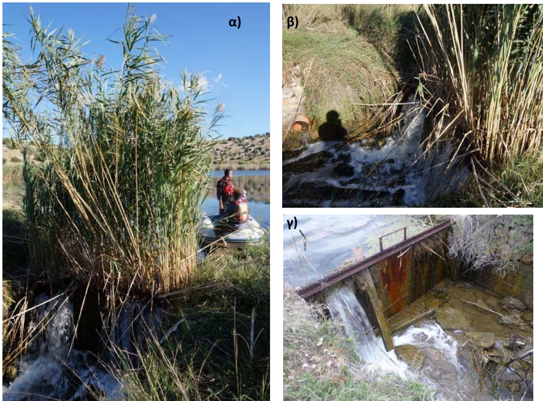
Εικ. 2. Το θυρόφραγμα στη δυτική πλευρά της λίμνης Κουμουνδούρου (α, β: ΕΚΒΥ 2017, γ: ΕΛΚΕΘΕ 2012)
