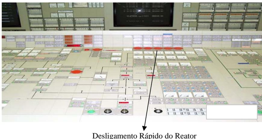
Figura 41: Controles de Desligamento Rápido do Reator
