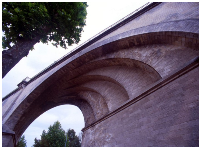
Figure 1-2 Voûte du pont biais à anneaux de Chartres [Photo de M. Sauvage - Direction de l'ingénierie SNCF].
