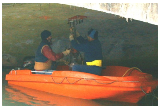
Figure 1-23 Carottage acrobatique sous la voûte [IN 2086, 2007].
