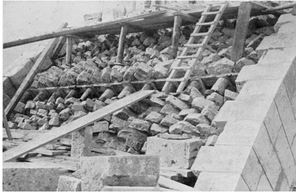
Figure 1-9 Construction du Pont d'Epinais sur Seine, 1906 [Séjourné, 1913]
