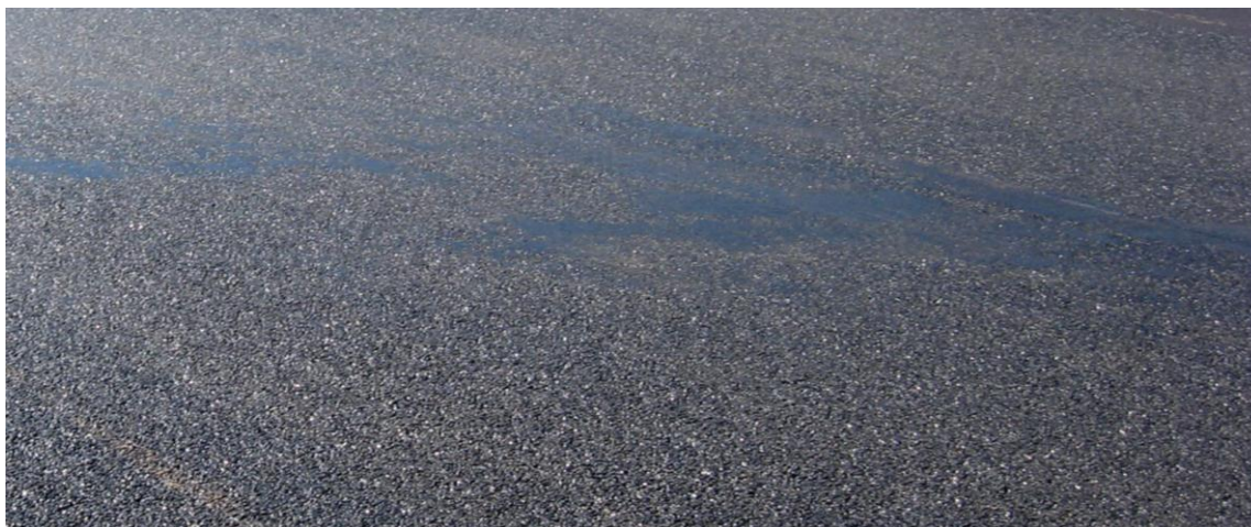
Slika 26: Iztisnjenje bitumenske malte (foto: Roman Bašelj)
