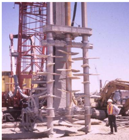
Slika 70: Mehanizacija za izvedbo globinskega mešanja (Grouting Committee, 2012)
