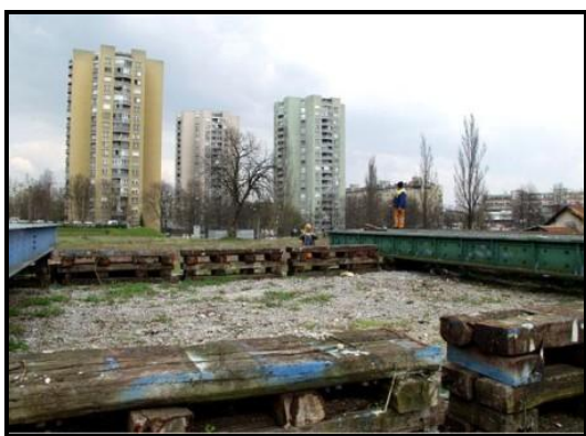
Slika 10: Stanje pred sanacijo območja
