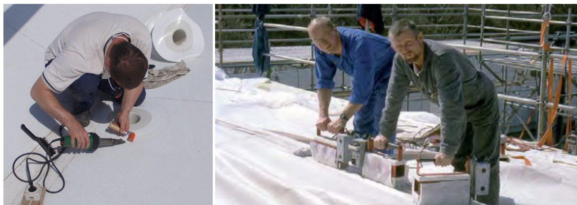
Slika 78: Levo: Varjenje dodatkov (PET/PVC) za odvodnjavanje z pištolo na vroči zrak; Desno: Varjenje FG/PTFE membran na gradbišču (Seidel, 2009)
