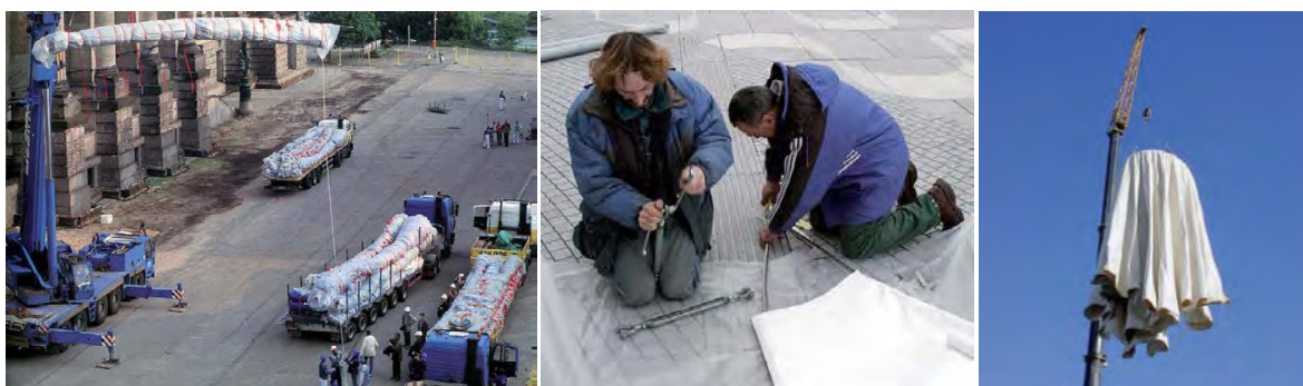
Slika 86: Levo: Dostava in razlaganje prefabriciranih membran; Sredina: Montaža kotnega spojnega detajla membrane; Desno: Dviganje razprte prefabricirane membrane (Seidel, 2009)
