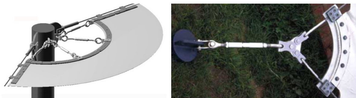
Slika 169: Primera možnih ogliščnih detajlov (Data ..., 2011; Tension structures ..., 2012)
