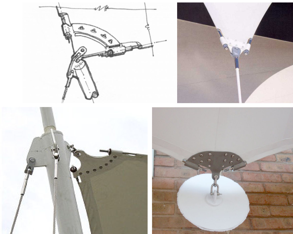
Slika 114: Različni primeri ogliščnih detajlov (Tension ..., 2010; Armijos, 2010b; How ..., 2011)
