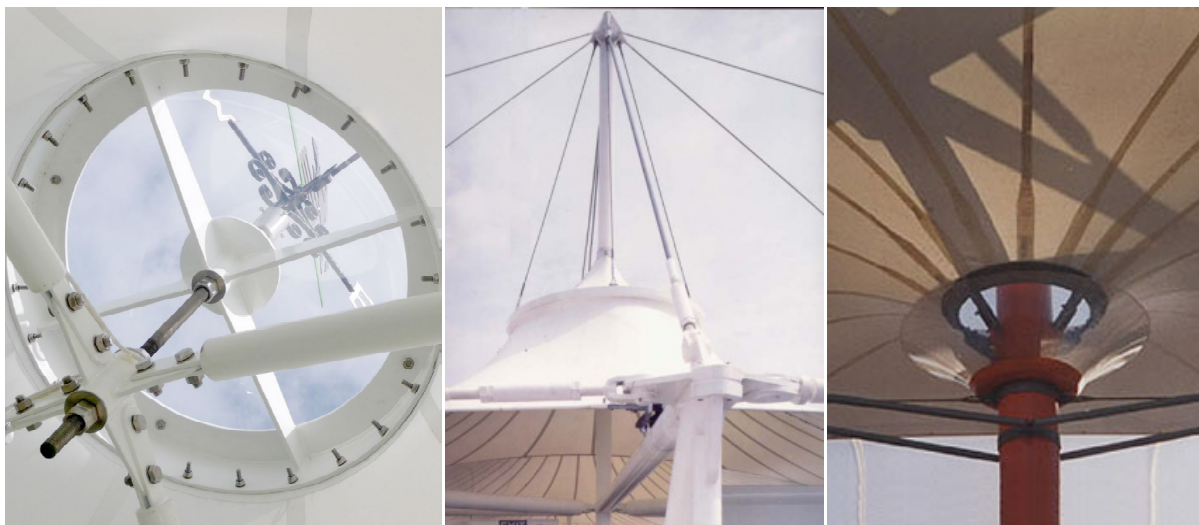
Slika 71: Različni primeri notranjih točkovnih podpor z nateznimi obroči (How ..., 2011; Data ..., 2011)
