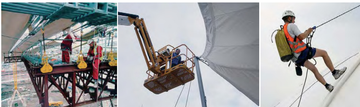
Slika 82: Levo: Viseči delovni oder; Sredina: Členkasta in teleskopska delovna platforma; Desno: Delavec pripet na varnostne vrvi
