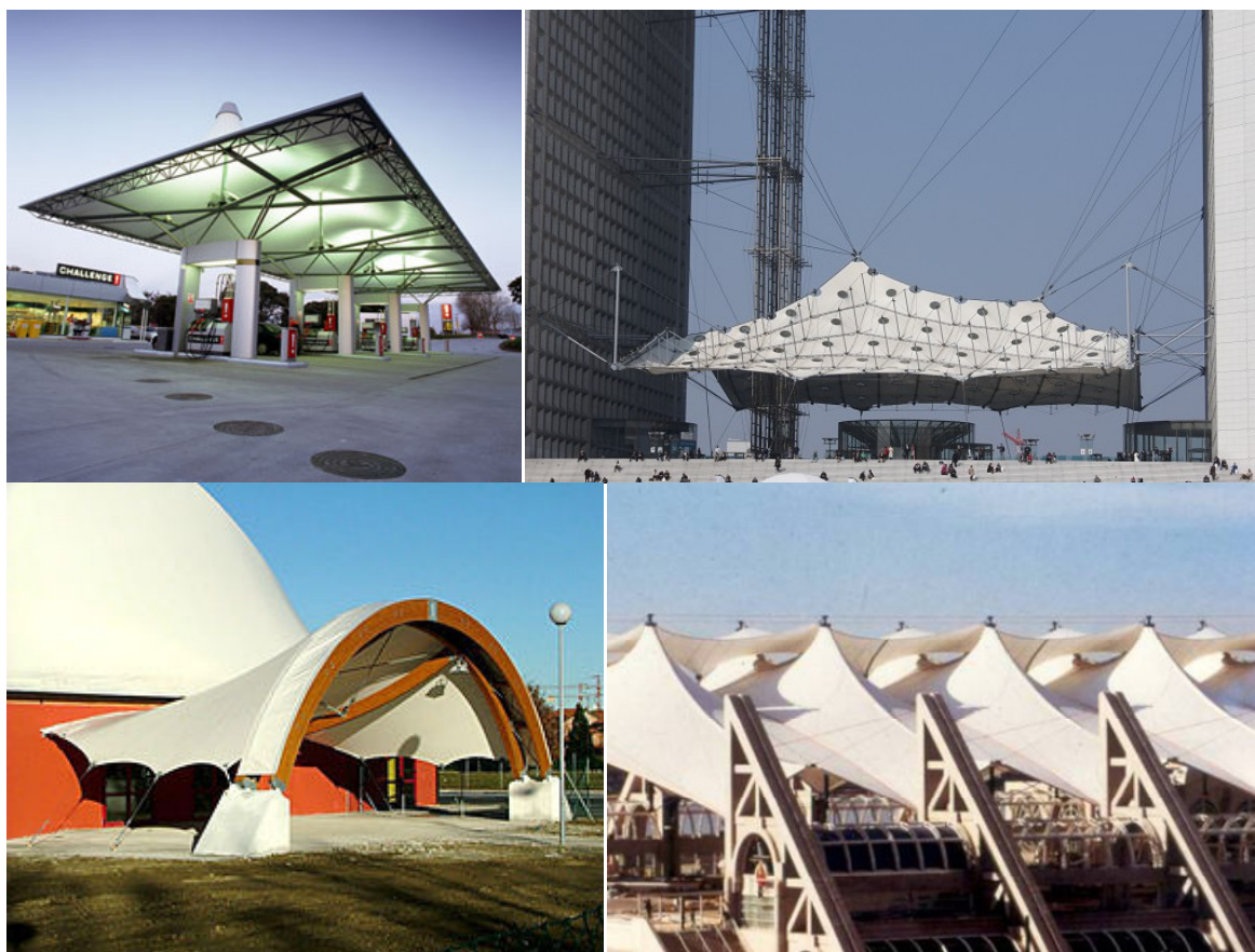
Slika 39: Primeri podpornih konstrukcij iz različnih materialov (Armijos, 2011; Janberg, 2010; Europlast, 2012; Schierle, 2009)
