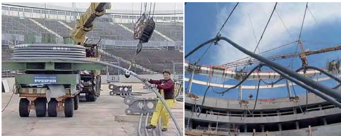
Slika 85: Levo: Razvijanje kablov iz bobnov na gradbišču; Desno: Dviganje kablov (Seidel, 2009)
