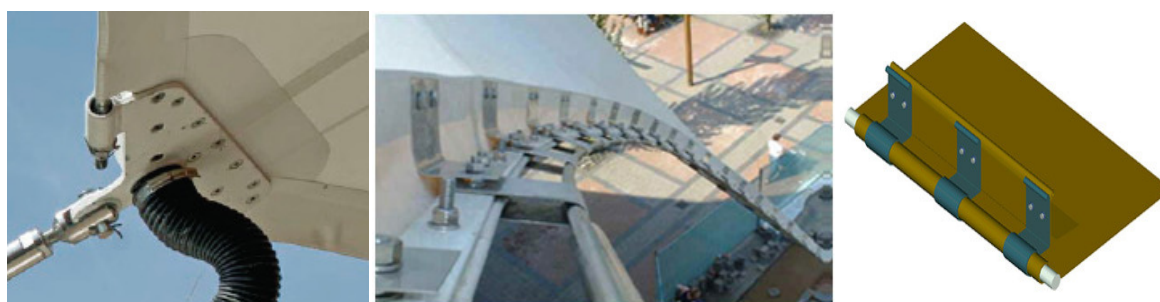
Slika 210: Možni detajli sistema za odvodnjavanje (How ..., 2010; Knowledge ..., 2011)
