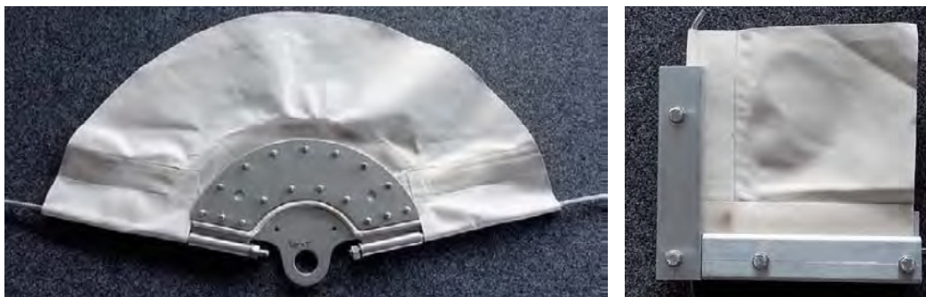
Slika 67: Levo: Kotni detajl pri fleksibilnih robovih; Desno: Kotni detajl pri togih robovih (Seidel, 2009)
