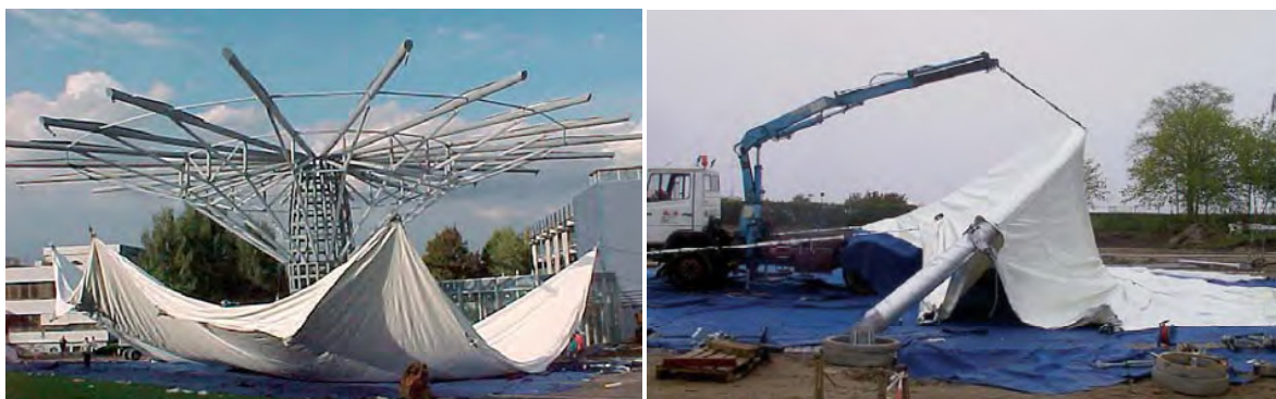
Slika 83: Levo: Pritrjevanje membrane na stabilno konstrukcijo marele; Desno: Dvigovanje ločnega nosilca skupaj z membrano (Seidel, 2009)
