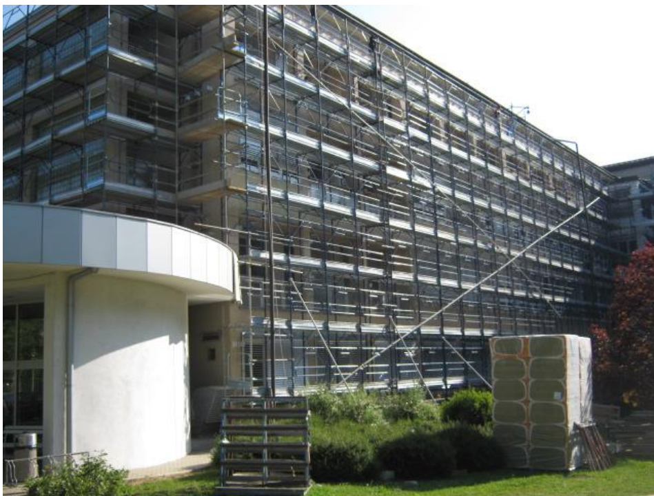
Slika 40: Postavitev odra na krak bolnišnice (foto: Mihelič, 2011)
