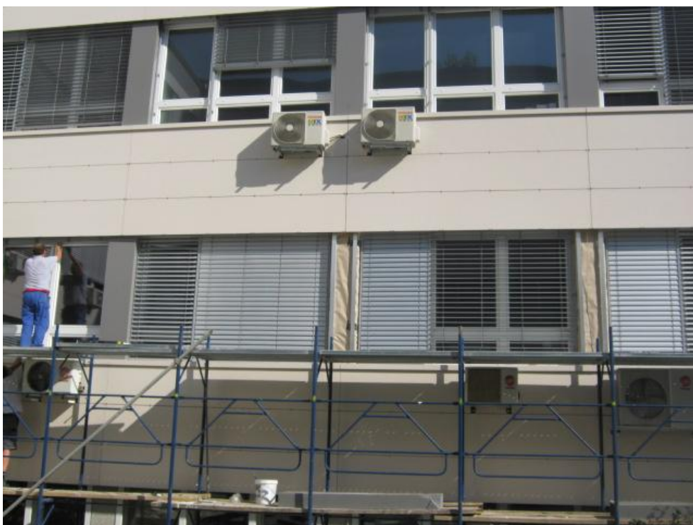
Slika 53: Lepljenje Kerrock plošče na vertikalne profile stebra (foto: Mihelič, 2011)
