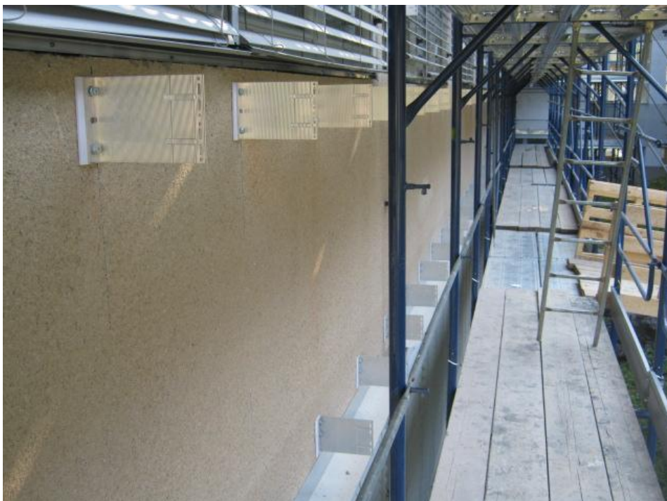
Slika 41: Montaža konzol na horizontalni pas med okni (foto: Mihelič, 2011)
