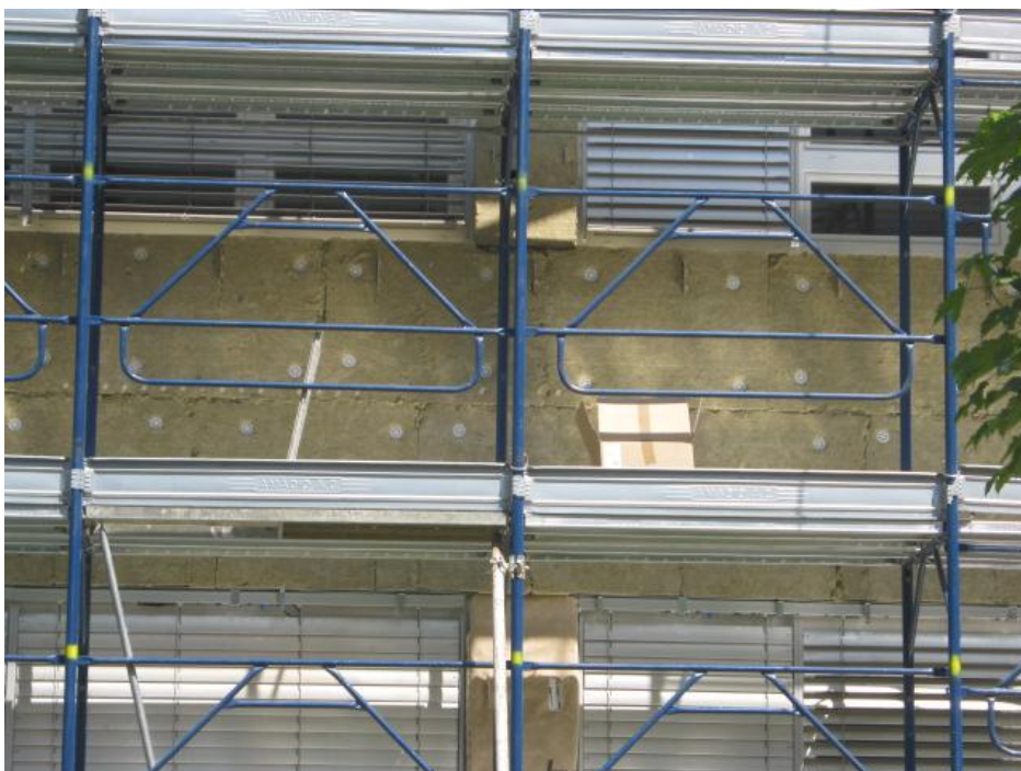
Slika 45: Sidranje toplotne izolacije po navodilih proizvajalca (foto: Mihelič, 2011)
