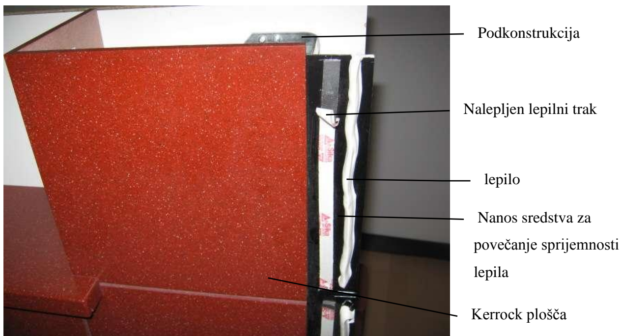
Slika 34: Prikaz lepljenja fasadne plošče na podkonstrukcijo (foto: Mihelič, 2011)
