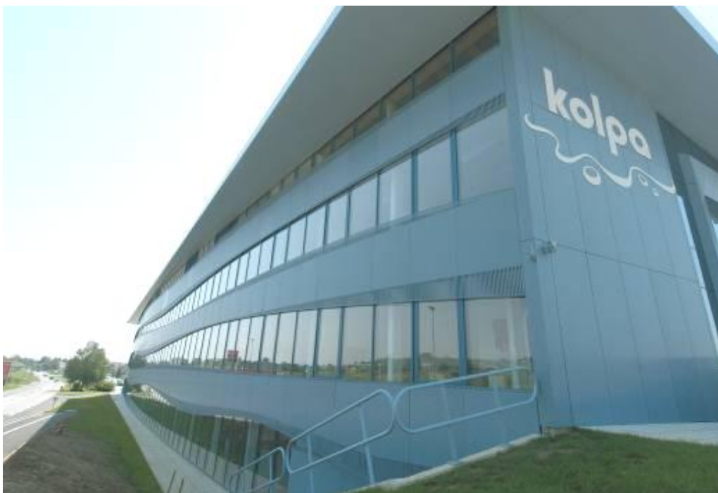
Slika 1: Salon v Metliki s prezračevano fasado iz Kerrock plošč
