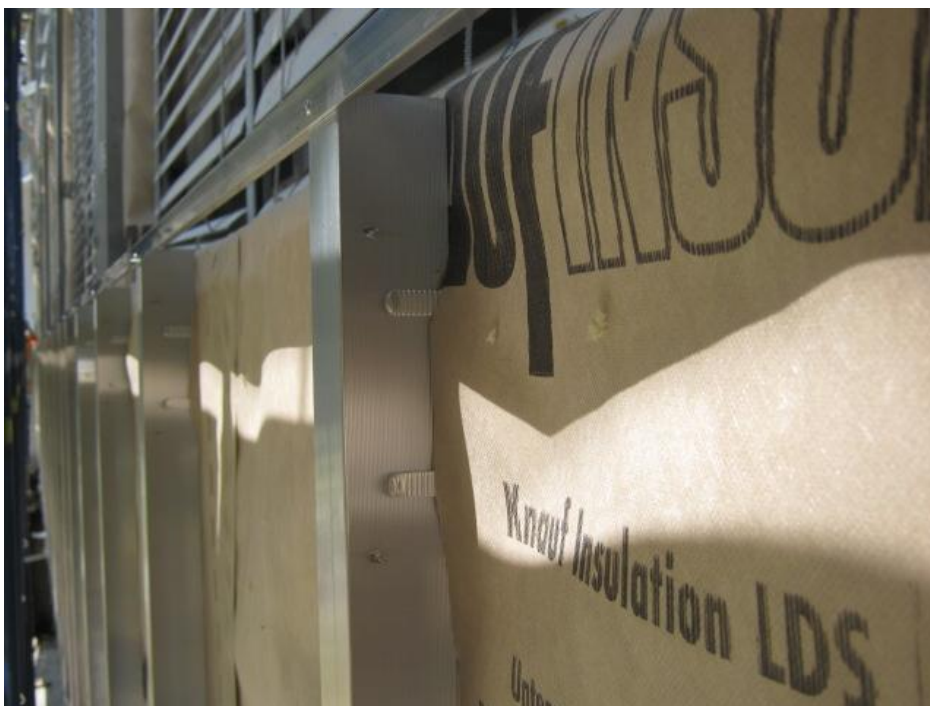
Slika 48: Montaža vertikalnih profilov na konzole (foto: Mihelič, 2011)
