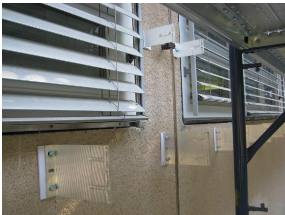
Slika 42: Montaža konzol na špaleta med okni (foto: Mihelič, 2011)
