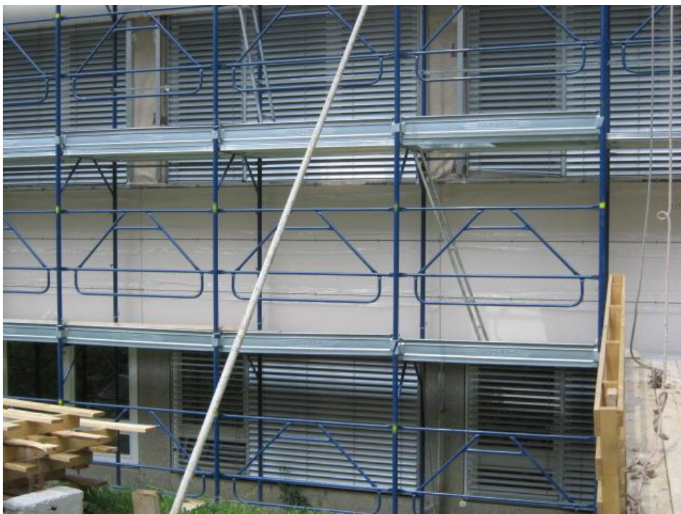
Slika 52: Pogled na horizontalni pas obešene prezračevane Kerrock fasade (foto: Mihelič, 2011)
