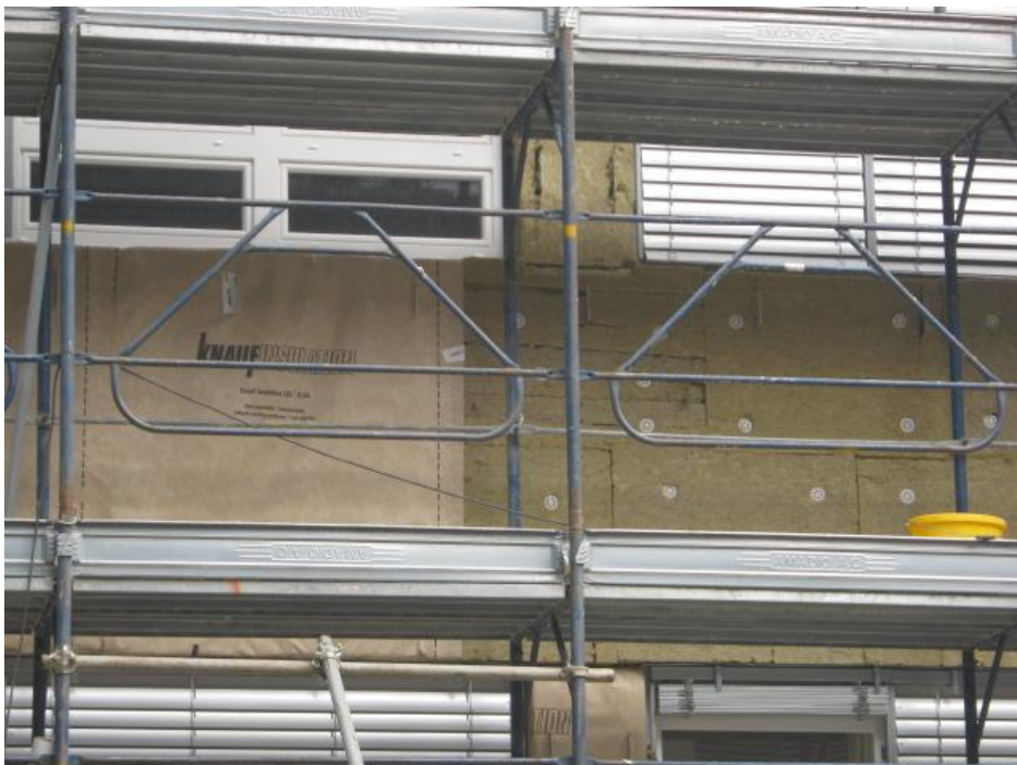
Slika 46: Lepljenje paroprepustne folije z lepilnim trakom proizvajalca (foto: Mihelič, 2011)
