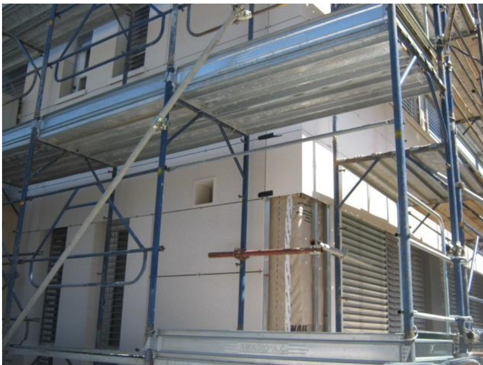
Slika 54: Detajl izvedbe vogala stavbe (foto: Mihelič, 2011)
