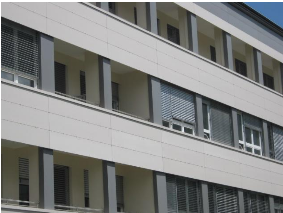
Slika 55: Izgled po odstranitvi gradbenega odra (foto: Mihelič, 2011)
