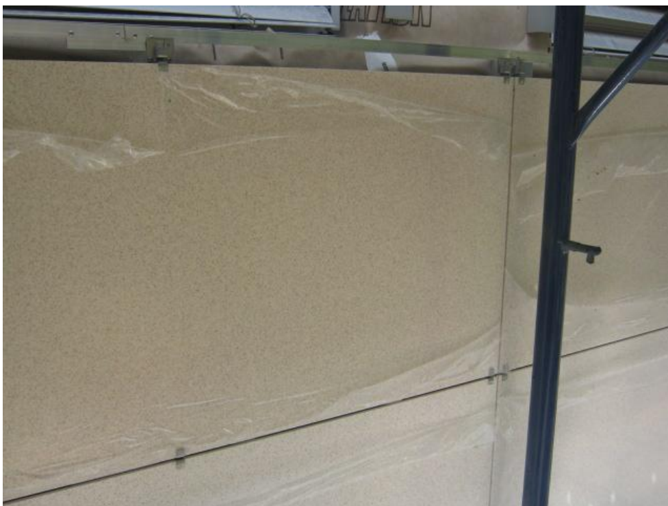
Slika 51: Obešena fasada je podprta na vsakih 76 cm (foto: Mihelič, 2011)
