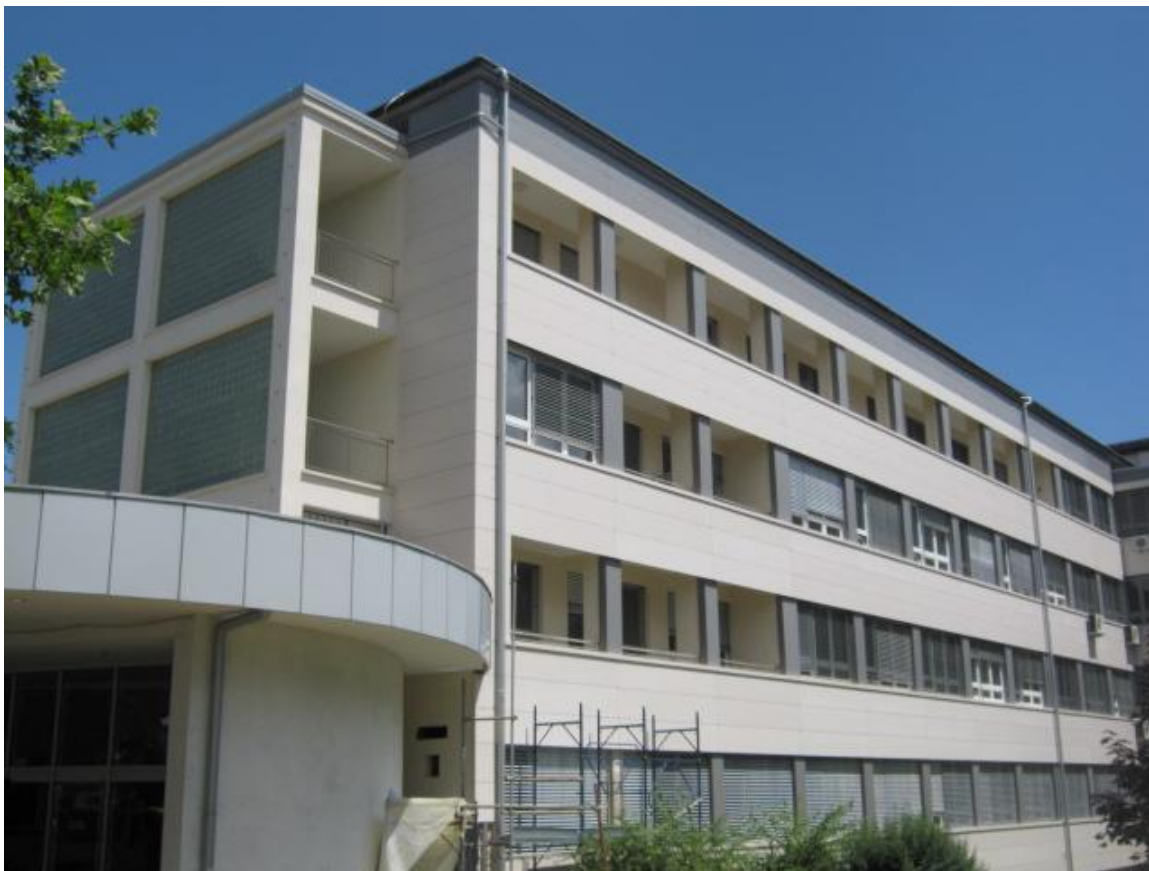
Slika 56: Končni izgled prezračevane Kerrock fasade na SBNM (foto: Mihelič, 2011)
