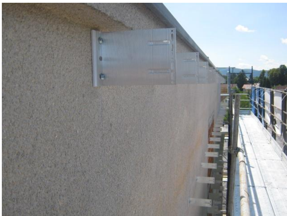
Slika 43: Montaža konzol na delu, kjer ni oken (foto: Mihelič, 2011)
