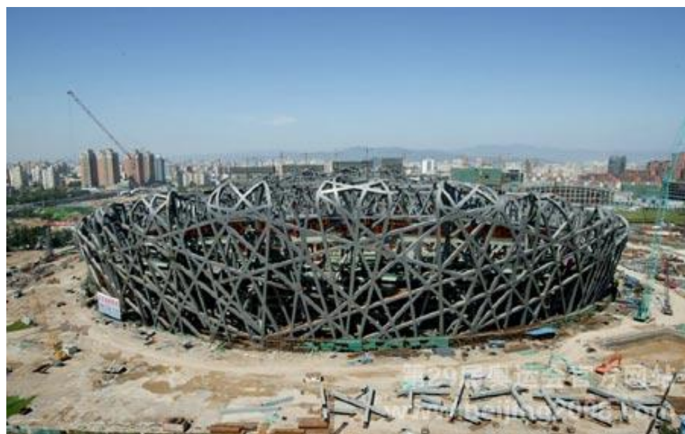
Slika 7: Prikaz poteka gradnje stadiona Bird's nest (Peking, julij 2006)
