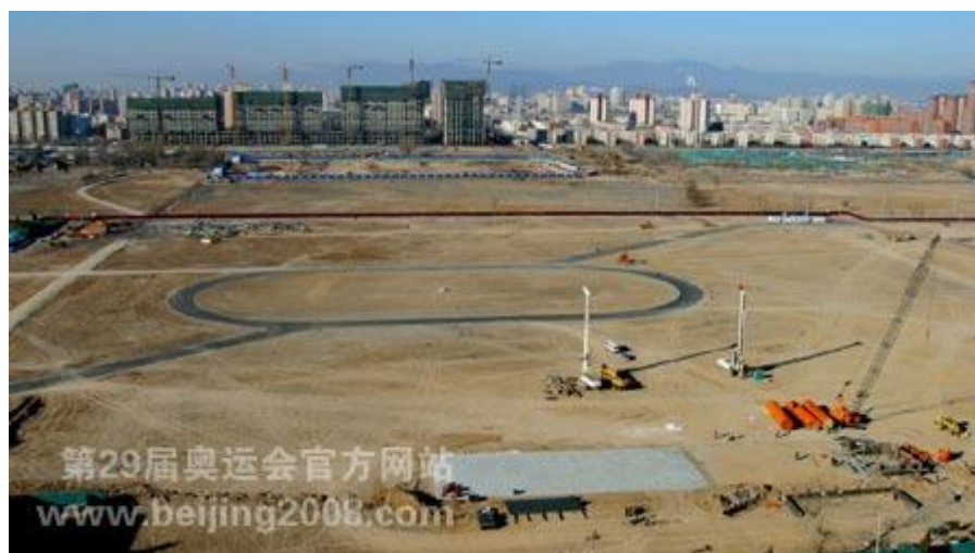
Slika 5: Prikaz poteka gradnje stadiona Bird's nest (Peking, december 2003)
