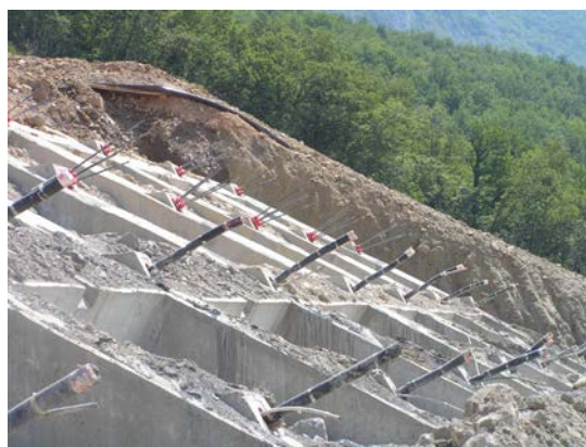
Slika 6.30: Stranski odzem Rebernice Z-10, branasta konstr.
