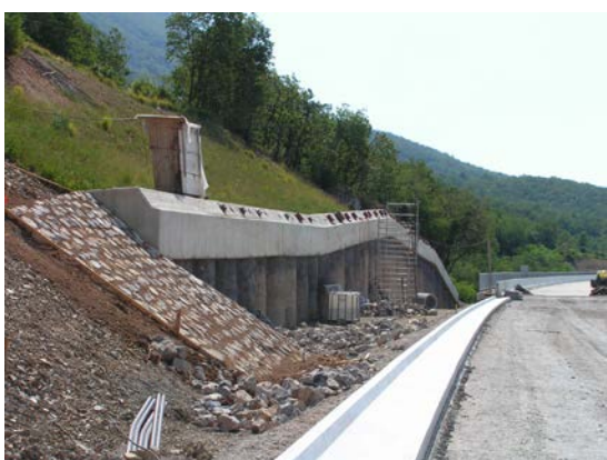
Slika 6.17: Pilotna stena Z-7 z druge strani
