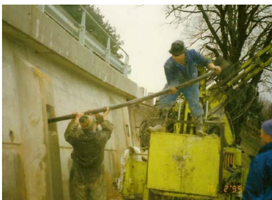
Slika 2.8: Vstavljanje in vgrajevanje sidra na cesti Col – Ajdovščina
