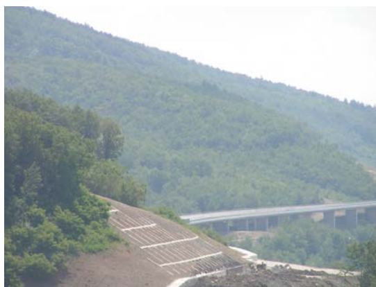
Slika 6.37: Pogled na viadukt in branasto konstrukcijo
