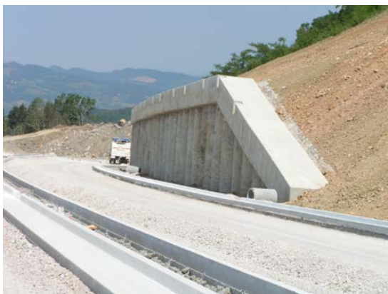
Slika 6.19: Pilotna stena Z-8
