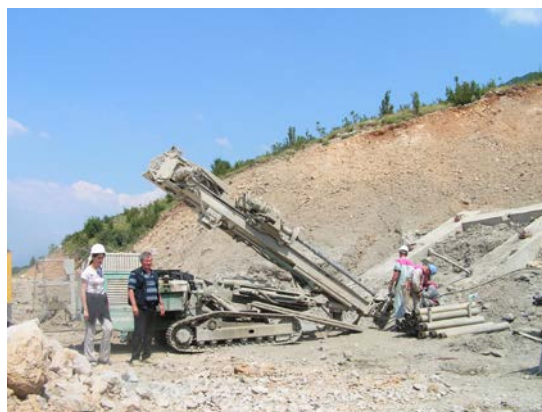
Slika 6.34: Vrtalni stroj v fazi izvedbe sidranja
