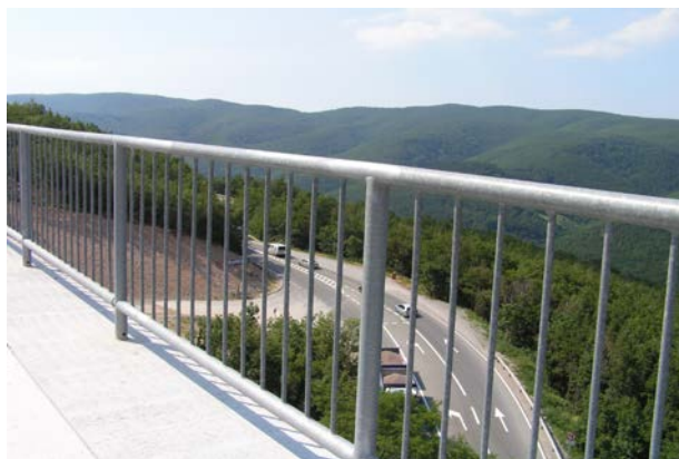
Slika 6.14: Pogled z viadukta na staro cesto
