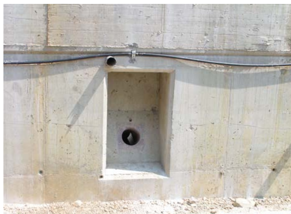
Slika 6.28: Rezervno sidrišče na pilotni steni P-4
