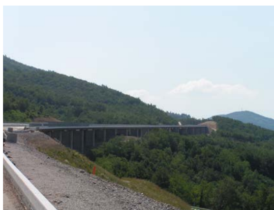
Slika 6.18: Pogled na viadukt
