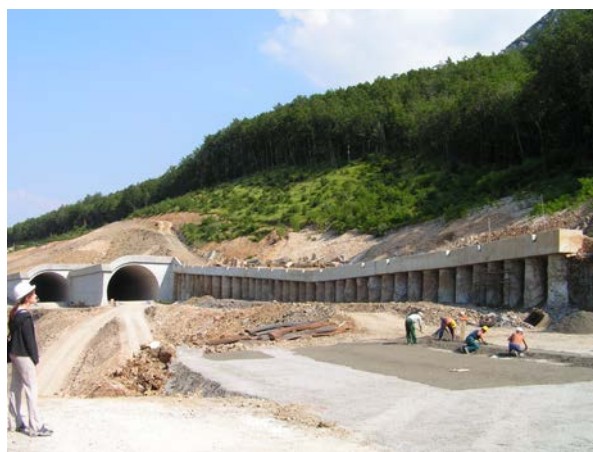
Slika 6.8: Pokriti vkop 8-2/2 s pilotno steno Z-5
