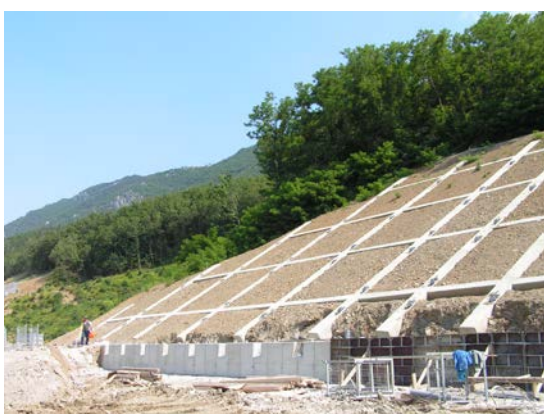
Slika 6.23: Opaževanje grede pod branasto konstrukcijo Pokriti vkop 8-4/1
