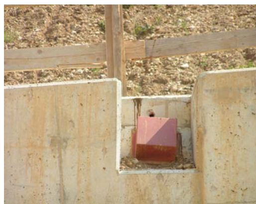
Slika 6.12: Sidrišče – zaščita glave sidra z jekleno kapo
