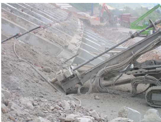
Slika 6.35: Vrtanje v flišu in grušču
