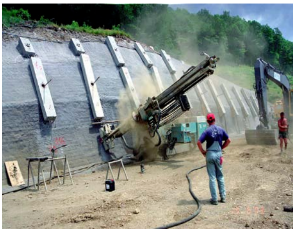
Slika 2.7: Vrtanje za vgradnjo sider
