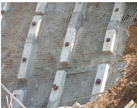
Slika 6.7: Sidrani slopi na pokritem vkopu
