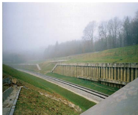
Slika 1.2: Sidrana pilotna stena - Mačkovci vkop Stanjevci
