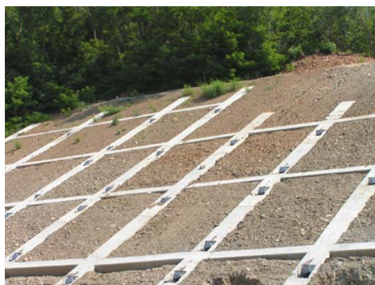
Slika 6.22: Sidrana branasta konstrukcija
