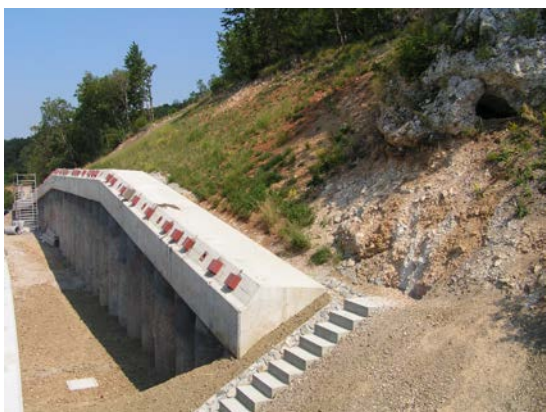
Slika 6.15: Pilotna stena Z-7
