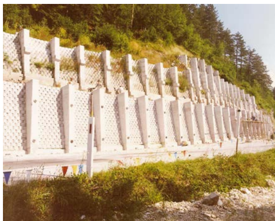
Slika 1.1: Varovanje brežine - sidrani slopi cesta Bohinjska Bela - Bled
