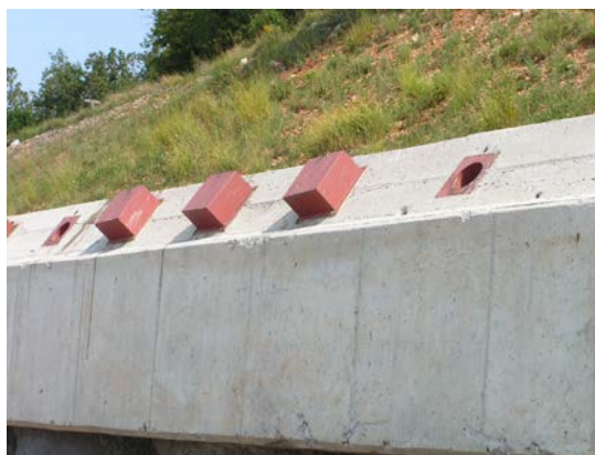
Slika 6.16: Pilotna stena s trajnimi sidri in rezervnimi sidrišči
