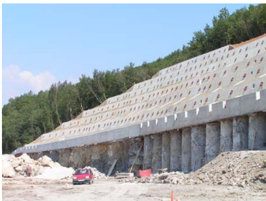
Slika 6.25: Pokriti vkop 8-4/1 s pilotno steno
