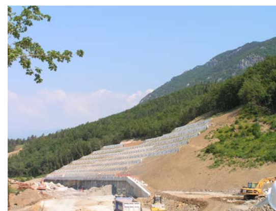
Slika 6.23: Opaževanje grede pod branasto konstrukcijo Pokriti vkop 8-4/1
