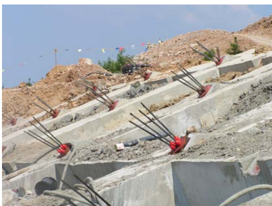
Slika 6.31: Napeta sidra na Z-10
