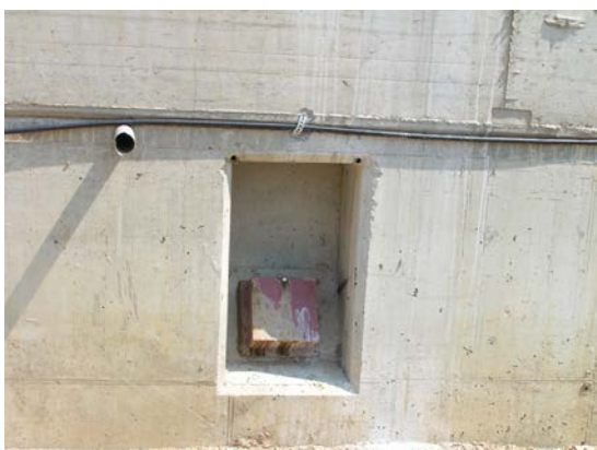
Slika 6.29: Zaščiteno trajno sidro na P-4
