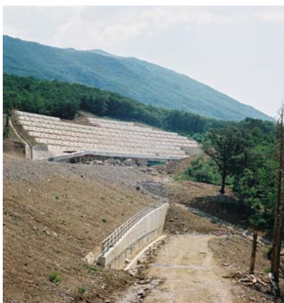
Slika 6.27: Varovanje zgornje brežine z 8-4/1 in spodnje brežine s P-4
