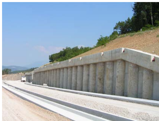
Slika 6.20: Z-8 brez vgrajenih sider na gredi, ker ni bilo potrebe
