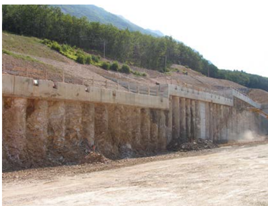
Slika 6.11: Pilotna stena za predorom
