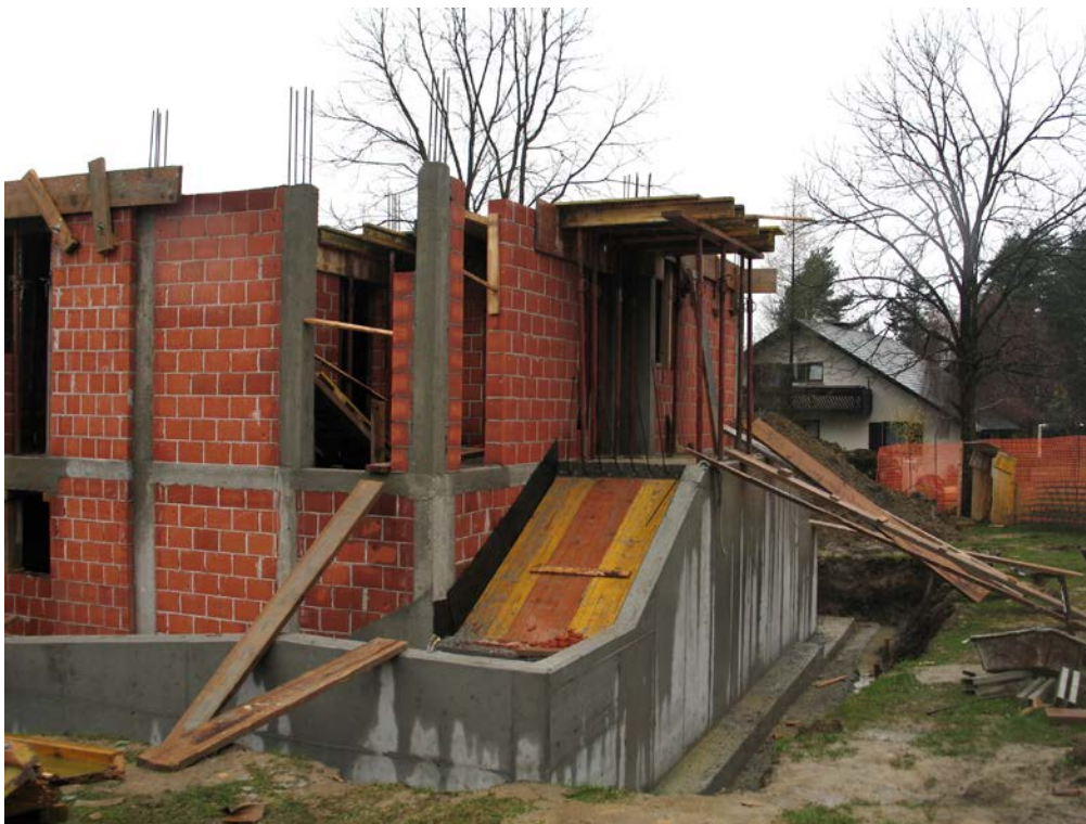
Slika 4.1: Ujeto zidovje - sistem navpičnih in vodoravnih zidnih vezi
