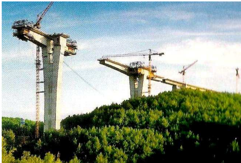
Slika 38: S prostokonzolno gradnjo se je gradil tudi črnokalski viadukt (vir: Dars d.d. Viadukti in mostovi na slovenskih cestah, str. 123).
