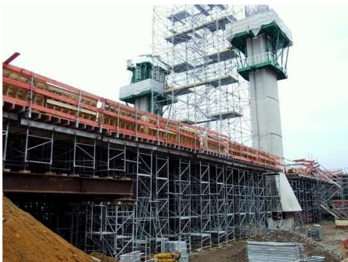
Slika 27: Podpiranje mostu s tal
