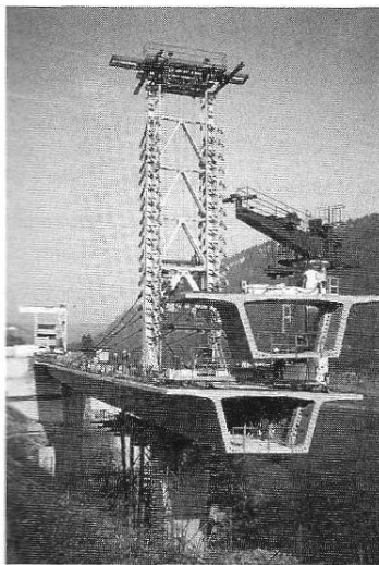
Slika 41: Segmentna gradnja
