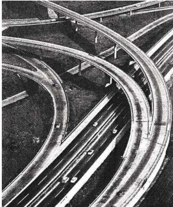
Slika 7: Gredni mostovi so zelo primerni za krivine, kjer se prepletajo prometni tokovi (vir: Leonhardt Fritz. 1994. Brucken: Asthetik u. Gestaltung, str. 137).
