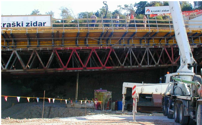
Slika 26: Nepomični oder, ki se opira na stebre (lastna fotografija).
