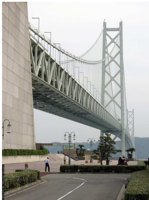
Slika 24: Viseči most Akashi Kaikyo ima najdaljši razpon med stebri-1991m
