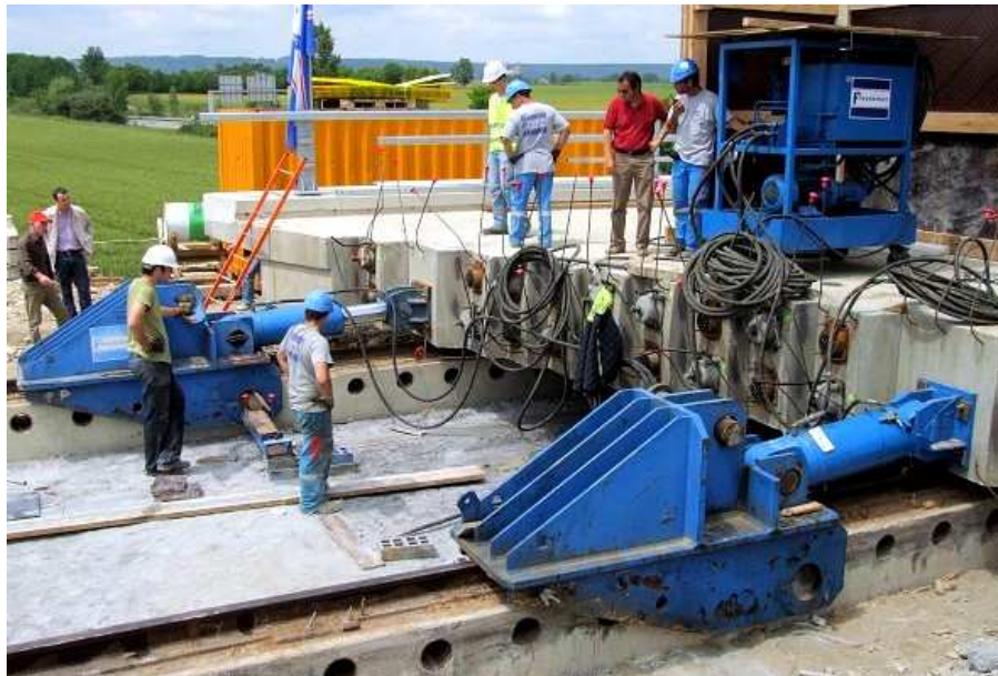
Slika 45: Narivanje poteka s pomočjo hidravličnih batov.
