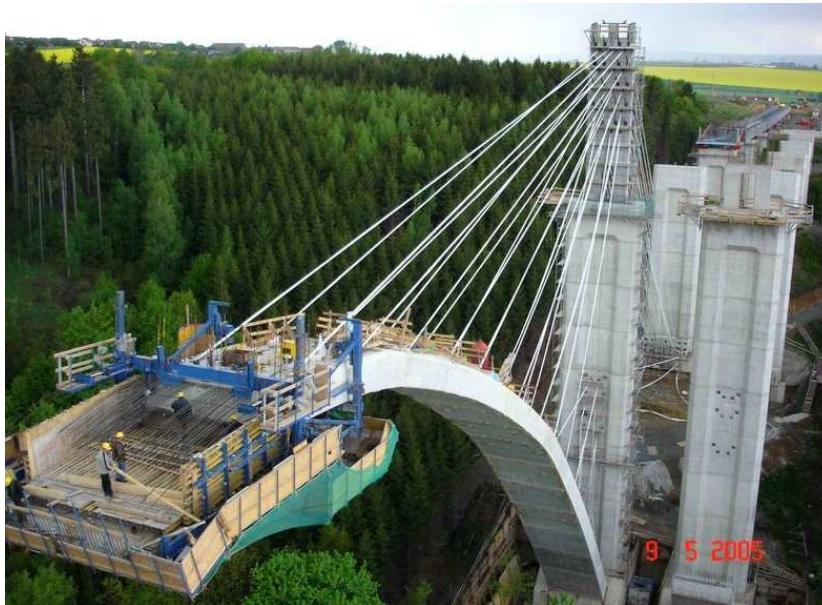
Slika 42: Podpiranje loka s pomočjo zateg in začasnega pilona
