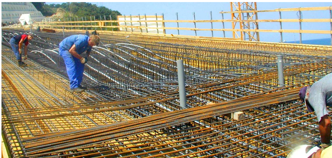
Slika 28: Vežanje armature (lastna fotografija).
