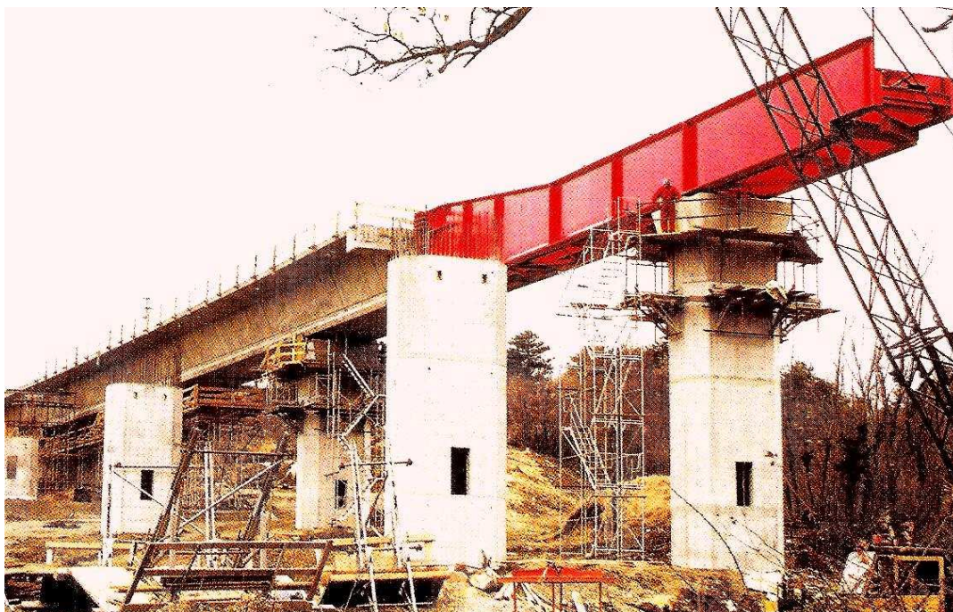
Slika 44: Med postopkom narivanja je na prekladno konstrukcijo pričvrščen jeklen kljun (vir: Dars d.d. Viadukti in mostovi na slovenskih cestah, str. XI)
