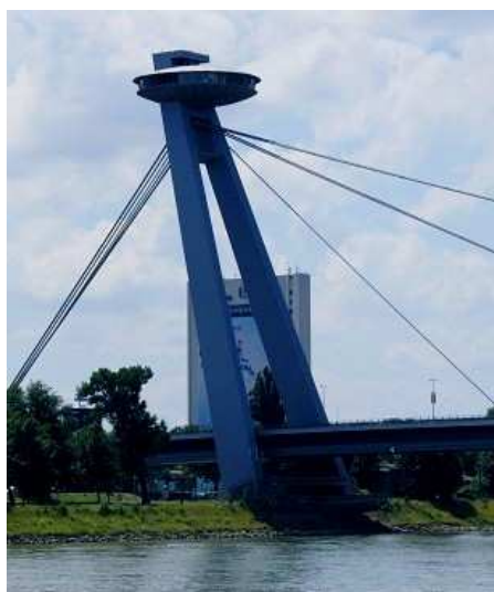
Slika 23: Nový Most v Bratislavi - nagnjen pylon
