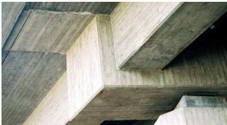
Slika 33: Monolitna povezava prečnika s T nosilci
