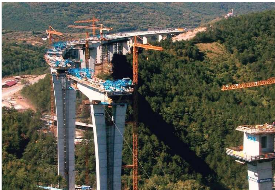
Slika 54: Potek konzolne gradnje Črnokalskega viadukta
