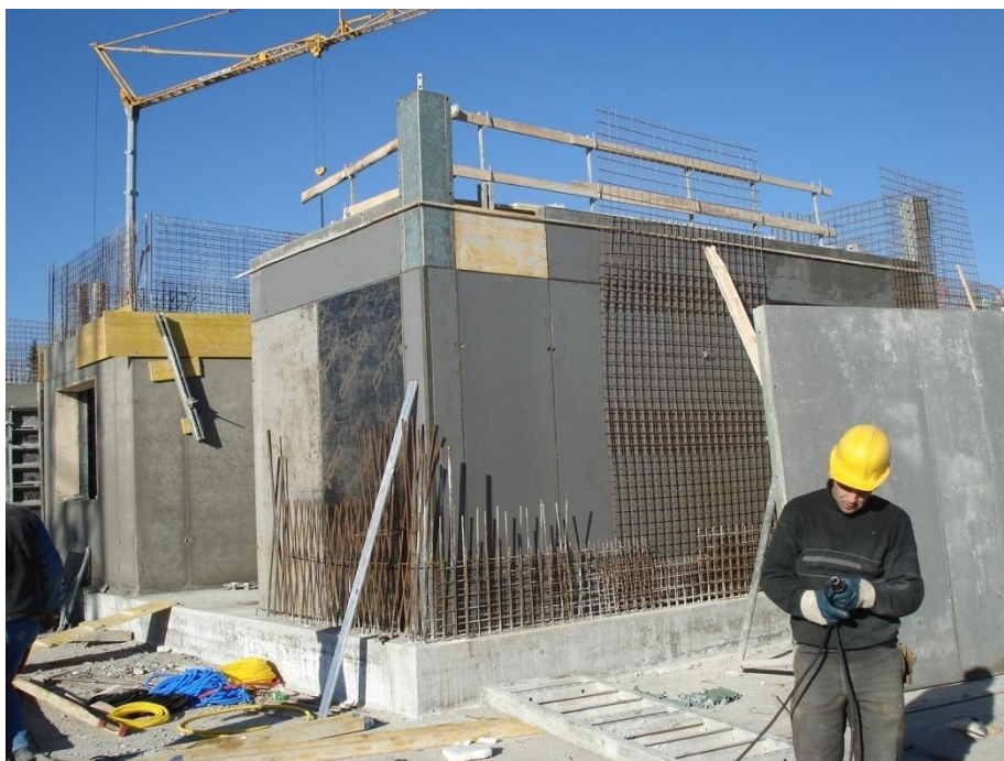
Slika 7: Način opaženja z DOKA FRAMAX XLIFE opažnim sistemom
