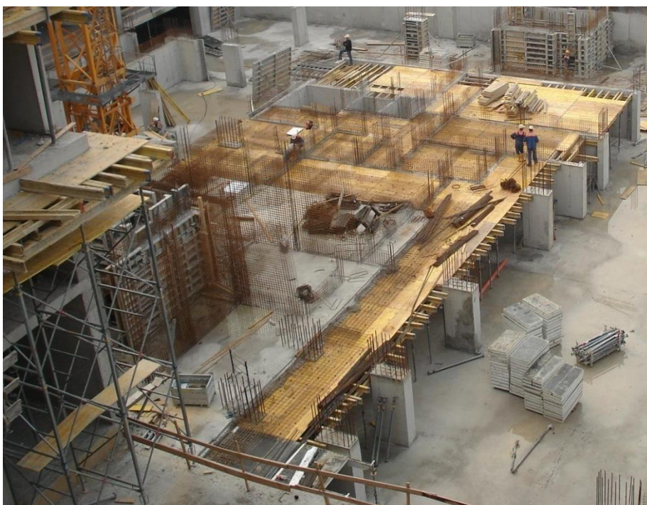
Slika 8: Način opaženja plošč z DOKA FLOOR SYSTEM elementi
