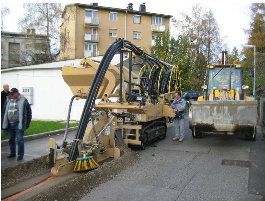
Slika 3: Prikaz najnovejše tehnologije izkopa in polaganja cevi (Gratel 2007)
