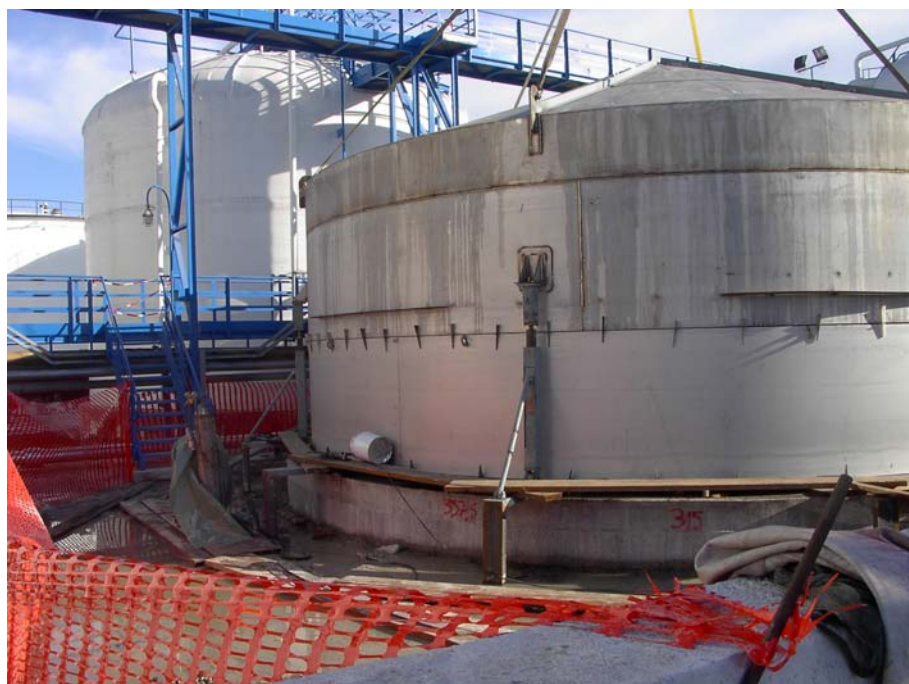
Slika 24: Gradnja rezervoarja – namestitev podpornih stebrov
