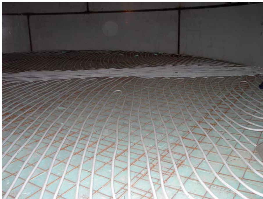
Slika 27: Grelna špirala vgrajena v dno rezervoarja
