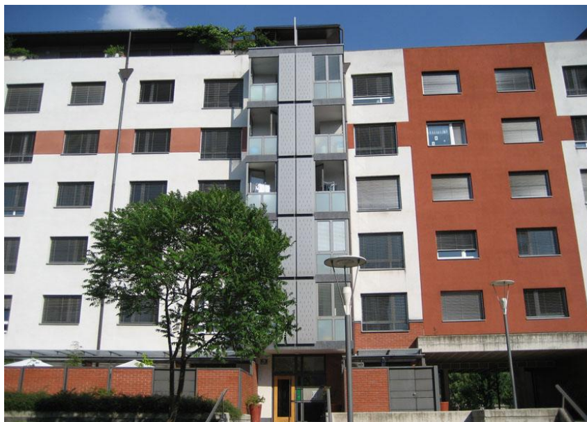
Slika 2: Jakopičeva 19, zahodna fasada
