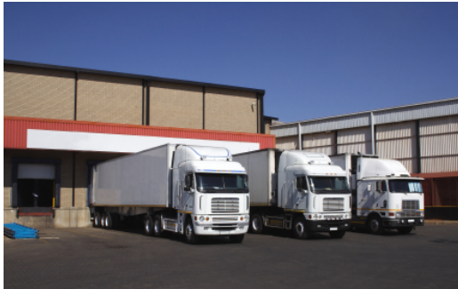
Depo Rampaları (Docks)
