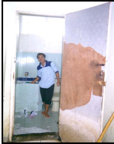
Gambar 3.5 Flow Meter di kamar mandi
