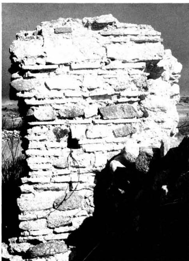
Biora. Particolare di un ambiente in opus vittatum mixtum delle terme di Sa Cresia.
