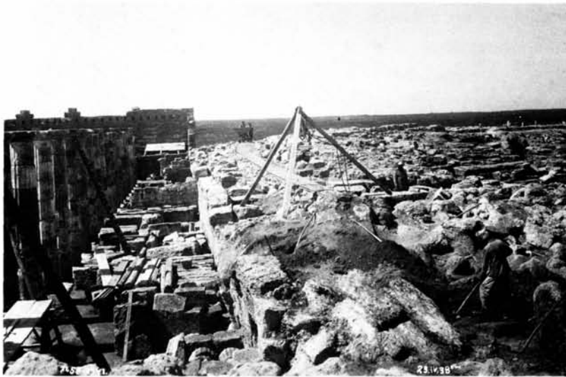
Resti dei muri delle botteghe ricavate sotto il portico ovest del Foro (scavo del 1938).
