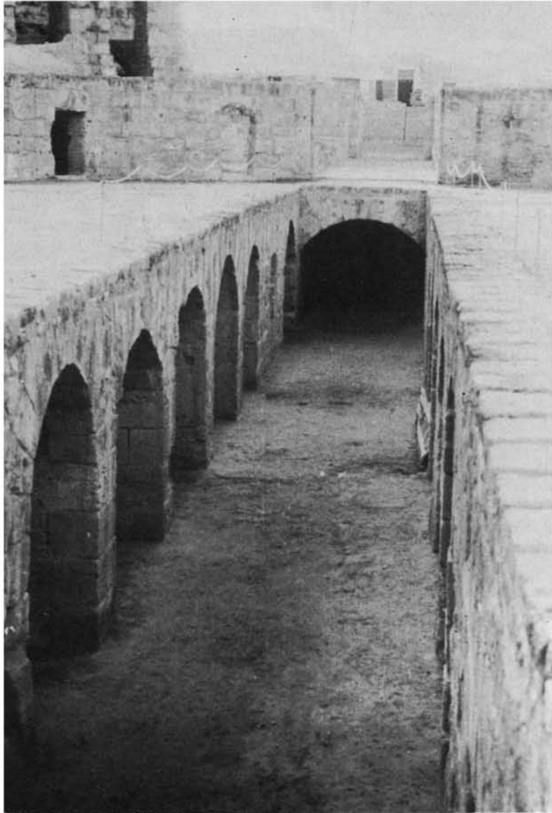
Le «Colisée d'El Jem»: souterrains.
