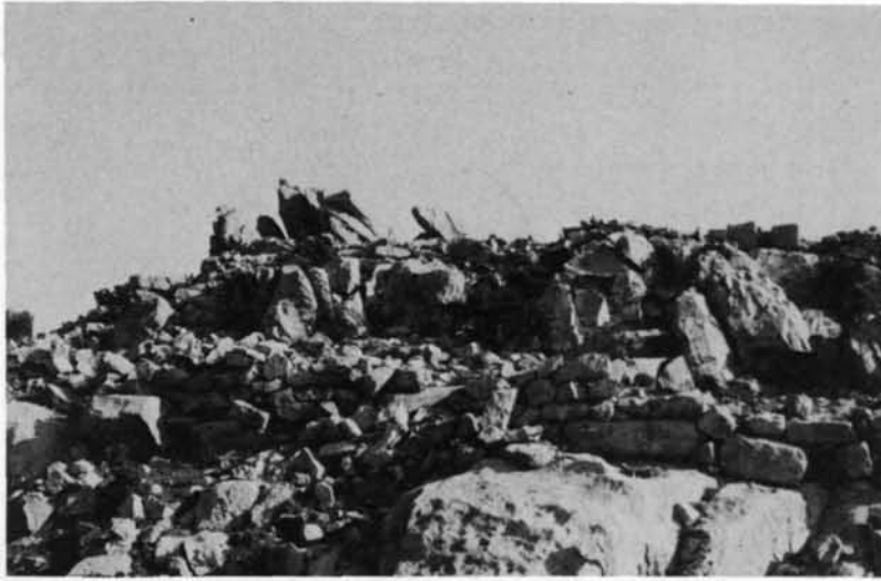
Ph. 1. Citadelle de Sidi Meftah: face nord, les deux enceintes.
